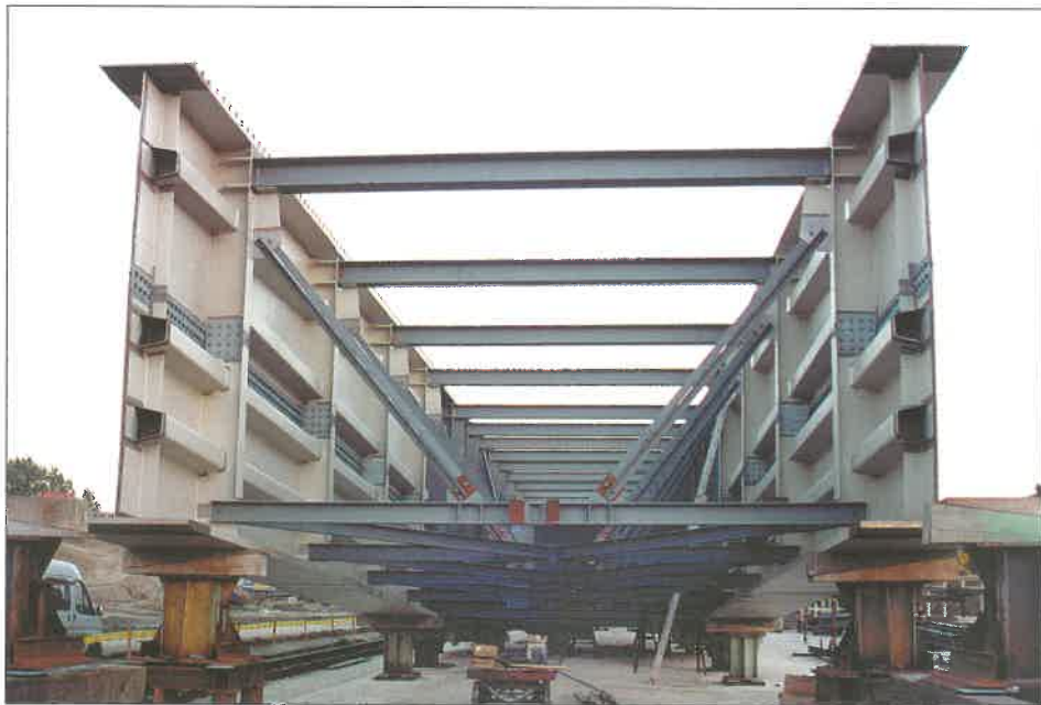
2. kép. A híd acélszerkezetének keresztmetszeti elrendezése
