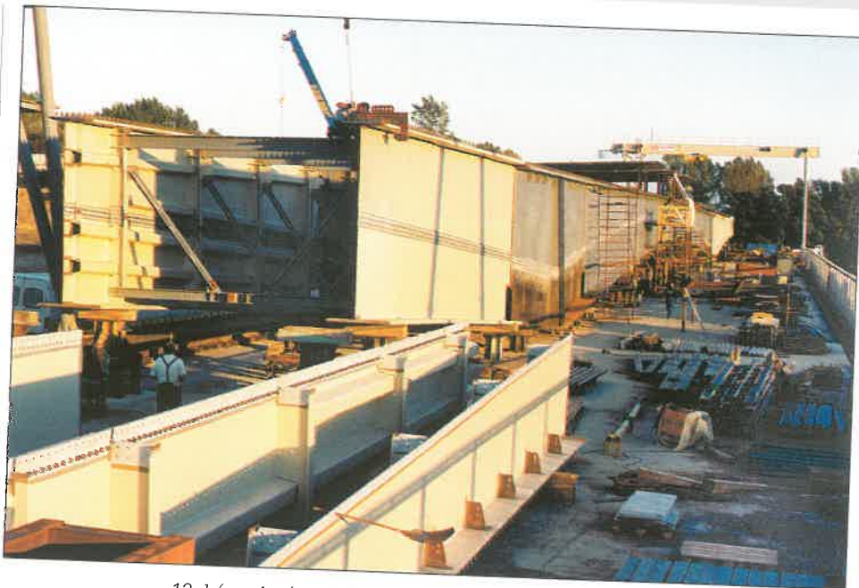
12. kép. Az északi híd a szerelés vége felé (2001.10.03.)
