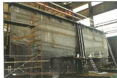
11. kép. Egy pillér feletti, 17 m hosszú, 5,5 m magas főtartó egység üzemi összeállítás alatt
