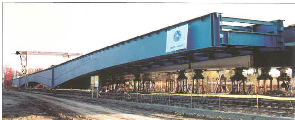
1. kép. Az északi híd kész acélszerkezete a behúzás kezdetén (2001.11.10.)
