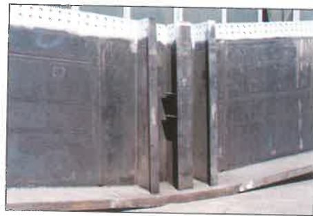
4. kép. A 3. képen látható főtartó egység külső oldalának támasz feletti részlete
