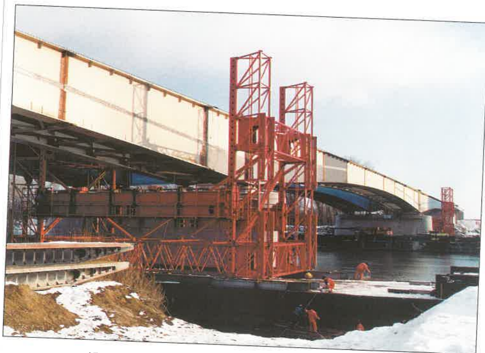
15. kép. A déli híd a pillérekön az egymástól 132 m-re lévő, csak a híddal összekapcsolt emelőművekkel
