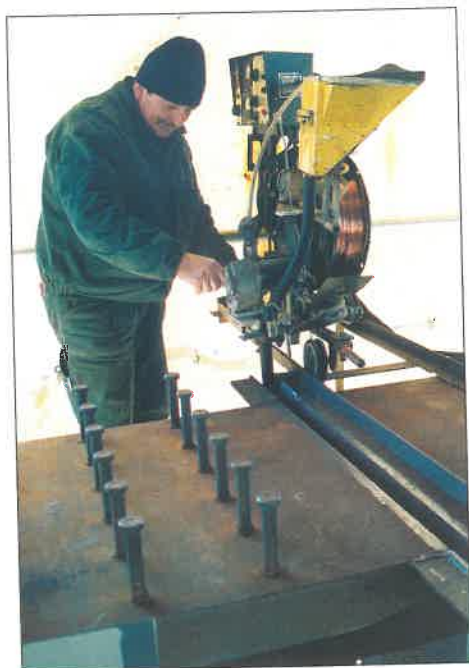
17. kép. A 80 mm vastag, 800 mm széles felső övlemez illesztő varratának hegesztése fedettívű automatával
