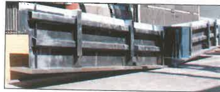
3. kép. Egy támasz feletti alsó főtartó egység belső oldala
