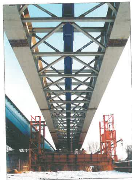
20. kép. A pillérre helyezett déli híd parti nyílása alulnézetben 2001.12.17-én
