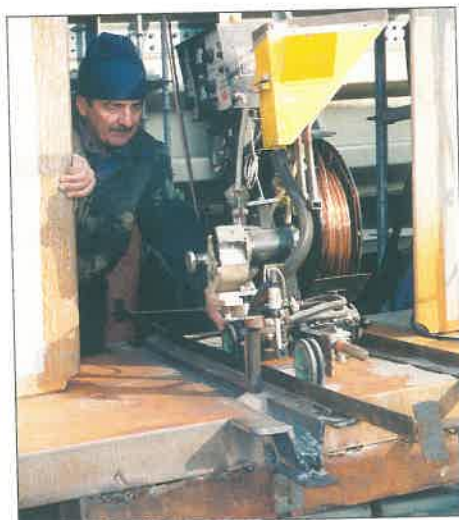
18. kép. A 100 mm vastag, 1200 mm széles alsó övlemez hegesztése fedettívű automatával, „ablakos” módszerrel
