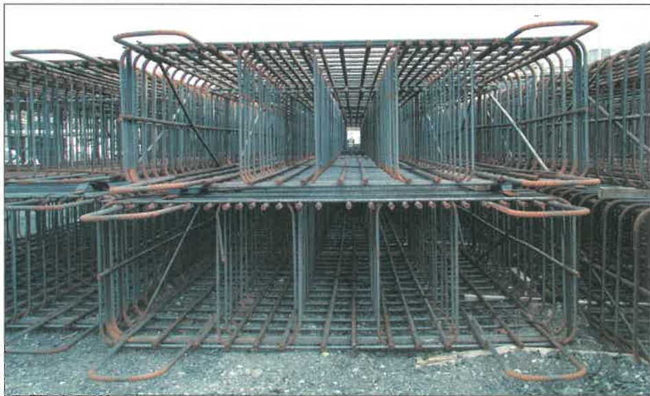
10. ábra. Résfal-elemek beépítés előtt
