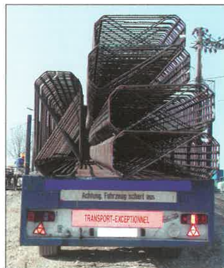
8. ábra. Nem körszelvényű betonacél-szerkezet
