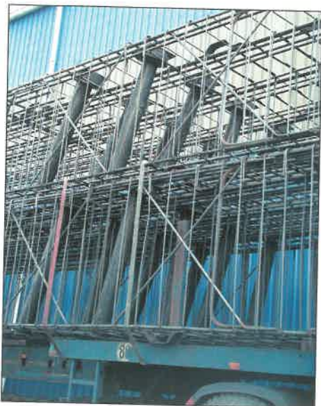
12. ábra. Csőátvezetések a későbbi lehorgonyzáshoz
