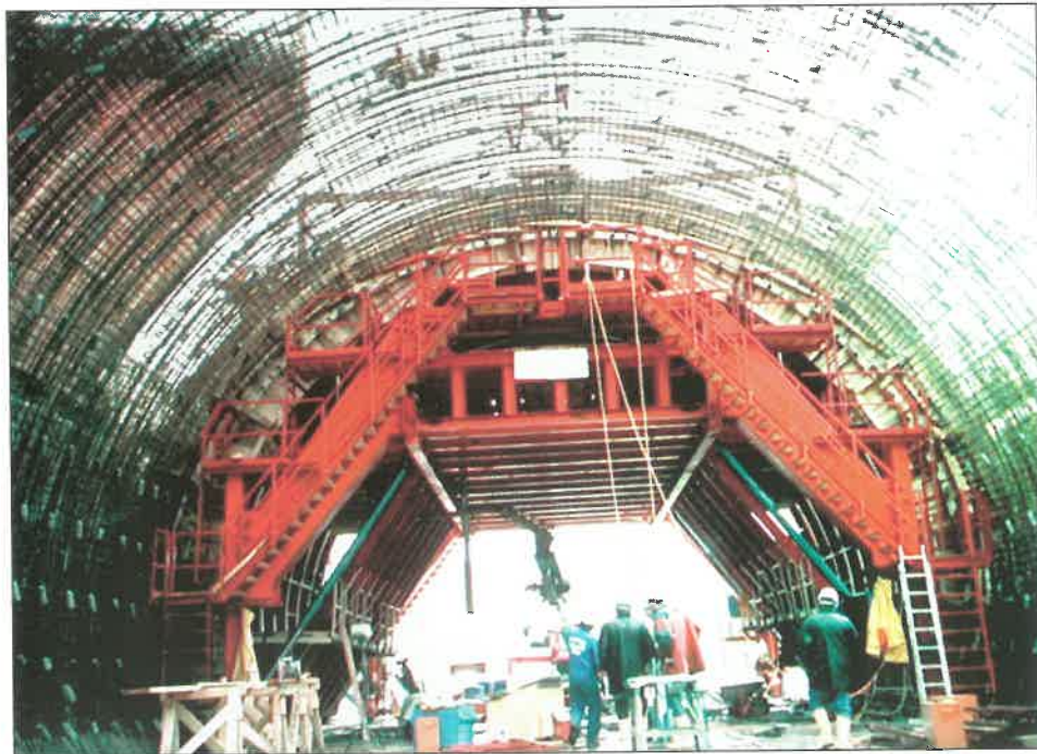
17. ábra. Nem elhanyagolható szempont a mozgózsalu teherbíró képessége betonozáshoz
