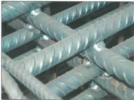
1. ábra. Betonacél-szerelvény több síkban hegesztve
