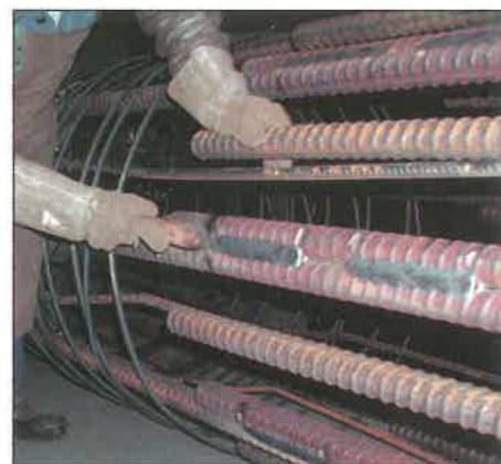
7. ábra. Előkészületek átlapolt varratok szemrevételezéséhez \phi 50 mm körszelvény esetén
