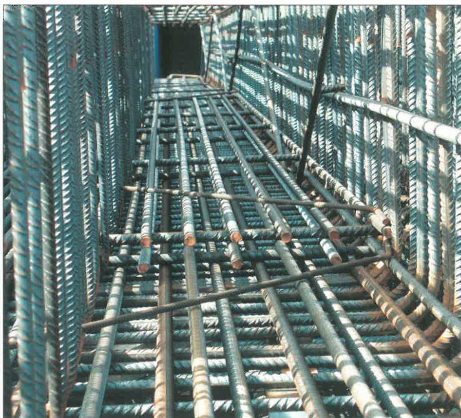
11. ábra. Fontos paraméter a betontöltő-nyílás akadálytalansága
