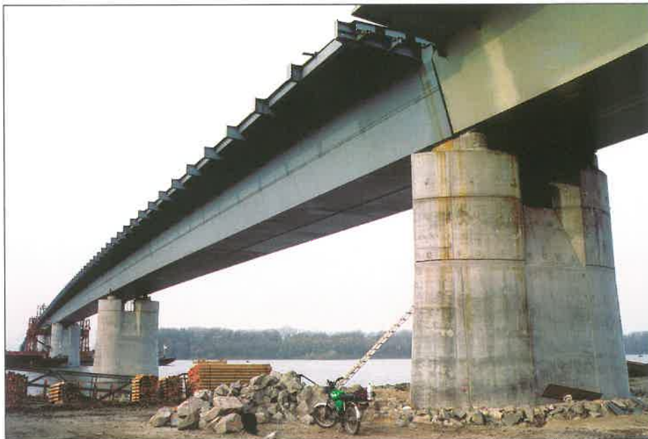
1. kép. Az ötnyílású ortotróp pályalemezes mederhíd a csatlakozó vasbeton pályalemezes bal-parti háromnyílású hídszerkezet részletével
