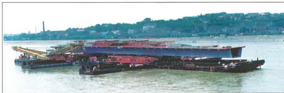
13. kép. A hajóvonta elindul egy 120 m hosszú, 700 t súlyú hídegységgel
