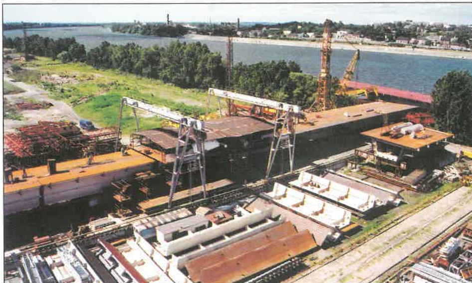
7. kép. A hídszakaszok összeállítása a csepeli előszerelő területen
