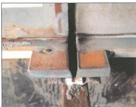
9. kép. A főtartó gerinc és fenéklemez illesztésének részlete kifutó lemezzel, kerámia alátéttel és az azt felszorító kamracsóvával
