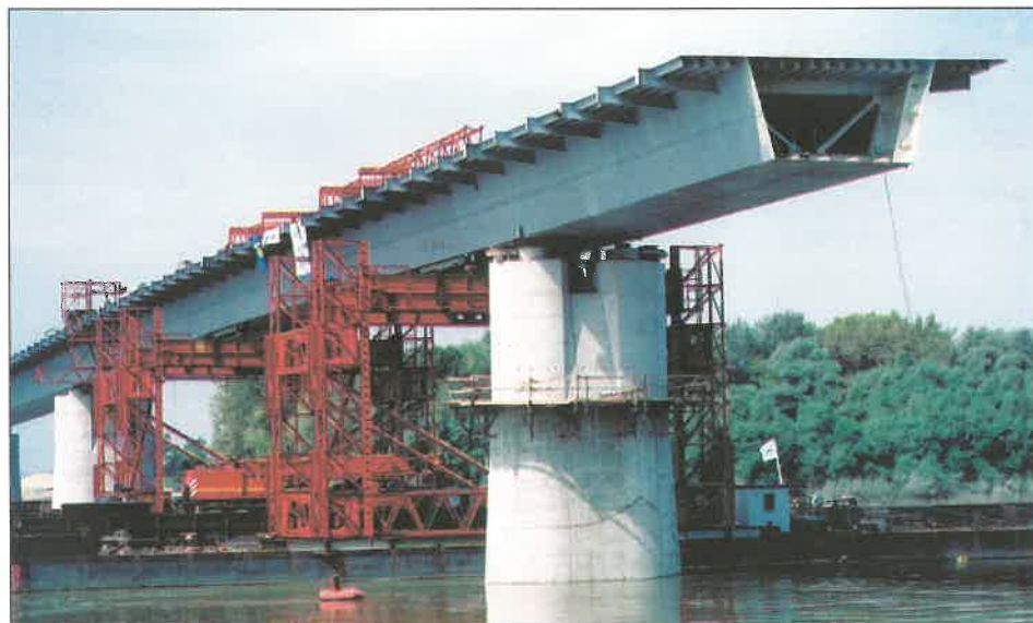
14. kép. A jobbparti 120 m-es nyílás beemelése az úszó-emelőművel
