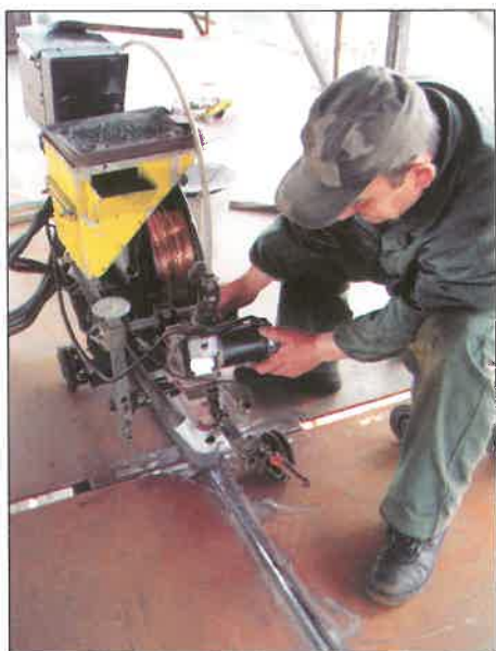
8. kép. A pályalemez hosszvarratának hegesztése fedett ívű eljárással (a szomszédos két egység közötti kb. 30 mm-es hézagot ideiglenesen beépített lemezen hidalják át)
