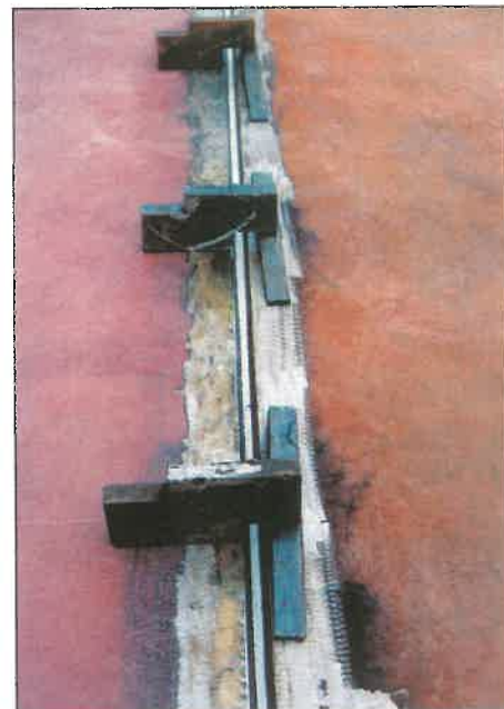
10. kép. A pályalemez illesztés a MAG alapsor hegesztésére előkészítve beépített kerámia alátéttel
