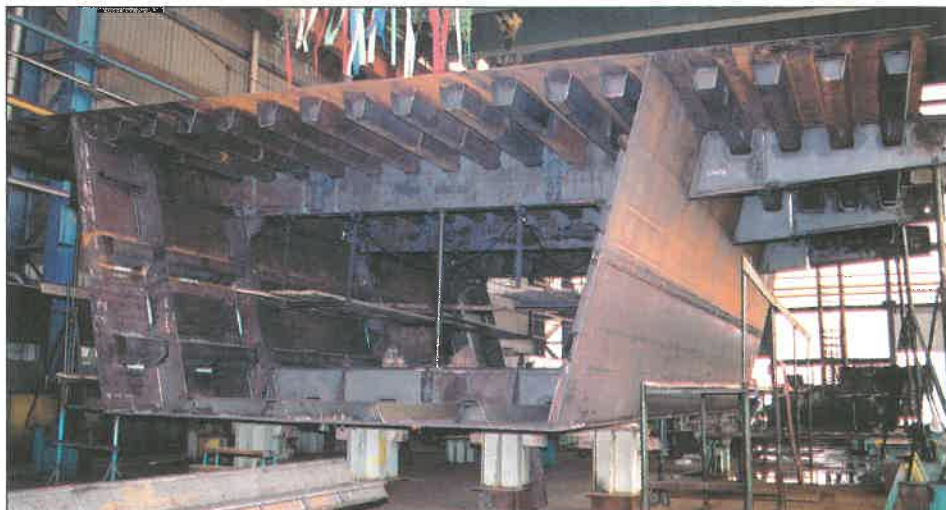
6. kép. Egy összeállított teljes hídkeresztmetszet
