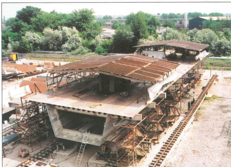
11. kép. A szekrénytartón kívüli hegesztési munka védőtetők és fóliasátrak alatt folyik
