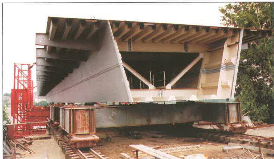
2. kép. Egy elkészült (107 m hosszú) hídszakasz a csepeli előszerelő telepen, az úszó-emelőműre történő behúzás közben
