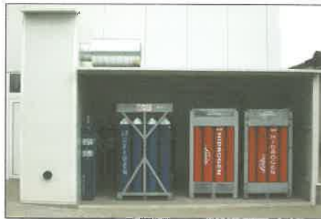
5. ábra. Négyféle plazmagázt és háromféle szekunder gázt szolgáltató gázellátó rendszer
