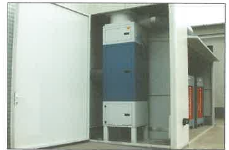
6. ábra. Automatikus tisztítású, szabályozott elszívó és szűrő rendszer
