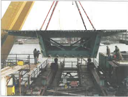
8. ábra Egy ártéri hídtag ráhelyezése az indító járomrendszerre
