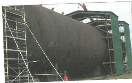
7. ábra. Tartályépítés III.
