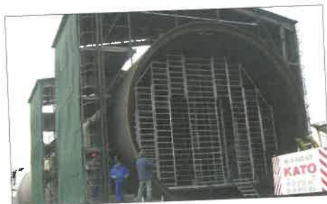
6. ábra. Tartályépítés II.
