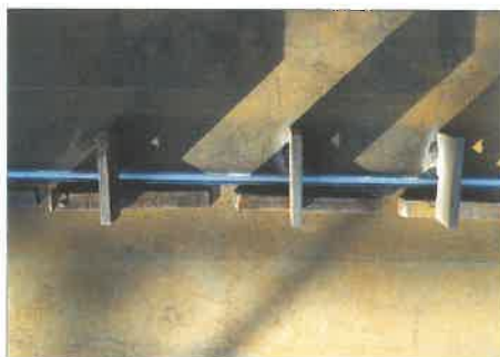
14. ábra Pályalemez egysíkúságának biztosítása ékekkel és „lakatok”-kal
