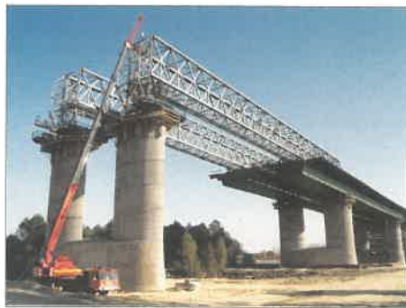
9. ábra Az ún. vendéghíd a betolási művelet közben
