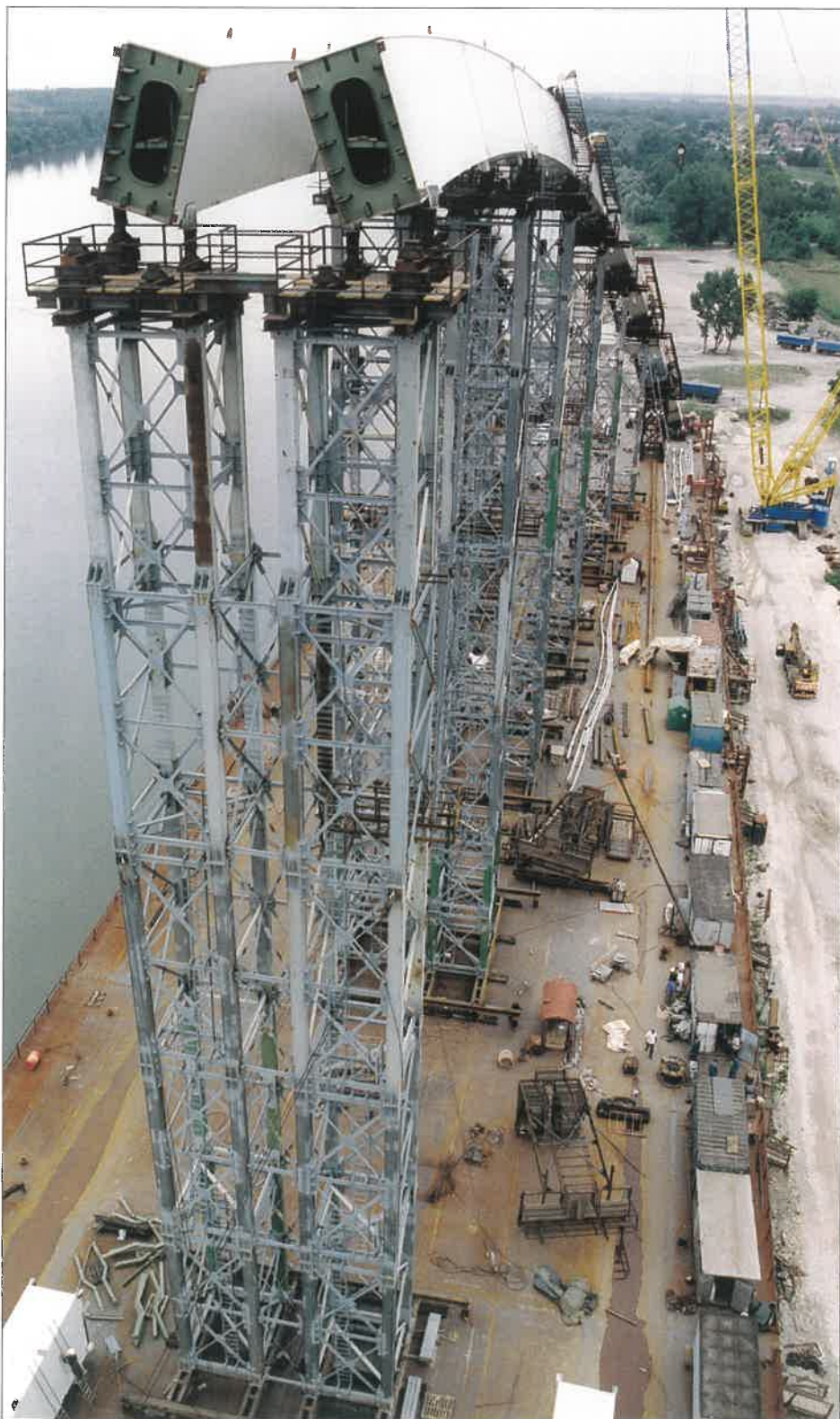
18. ábra. A monumentális ív szerelése tetőpontjához érkezett. Könnyű belátni, hogy ilyen helyeken csak egy kis, egyszerűen mozgatható áramforrás fér el, tehát az illesztések elkészítésére csakis a 111-es eljárás jöhet szóba
