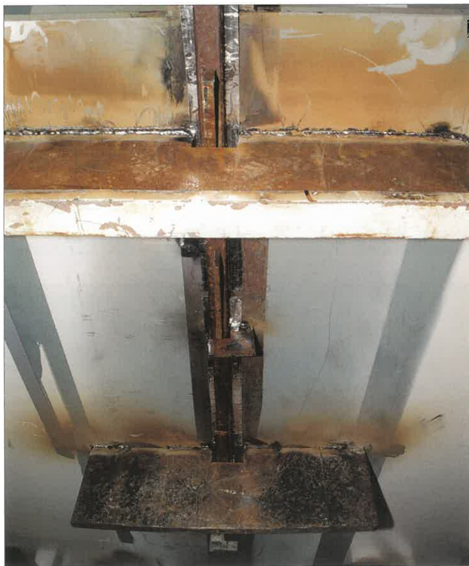
15. ábra. A kerámiafűrdő biztosítás rögzítése, mely egyben a szögzsugorodás okozta alakváltozás megelőzését is szolgálja
