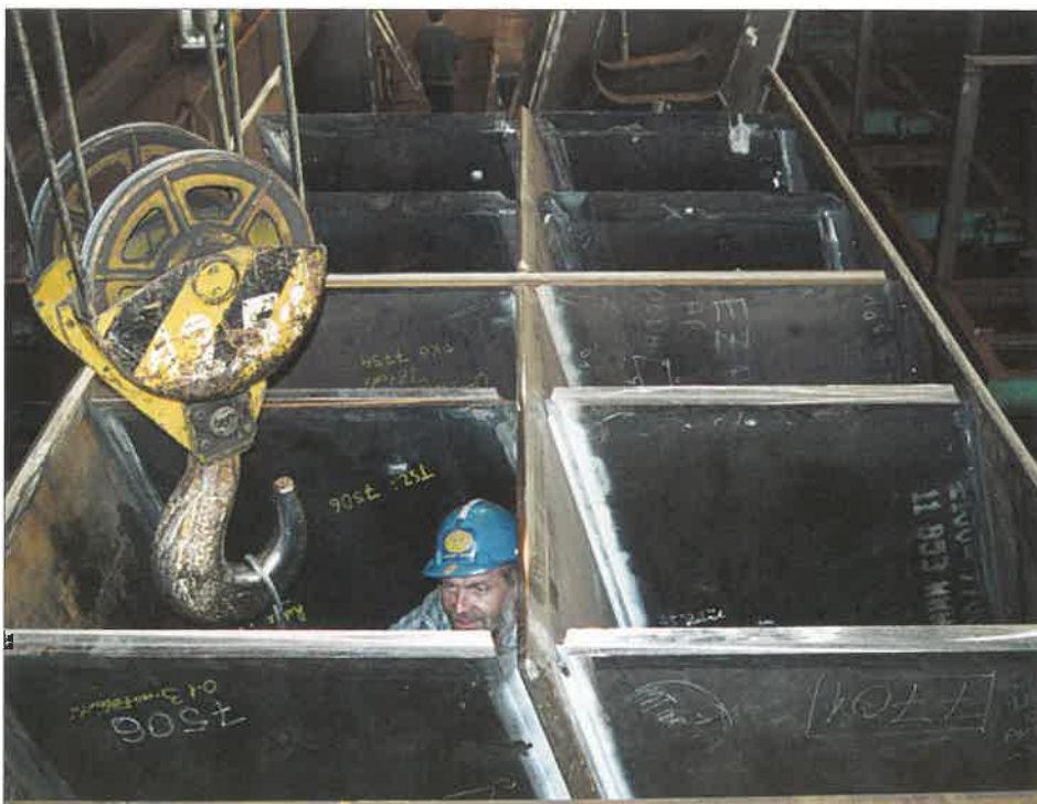
5. ábra. A főtartó ívcsatlakozásánál lévő, 70 mm vastag lemezekből álló részének üzemi kivitelezése
