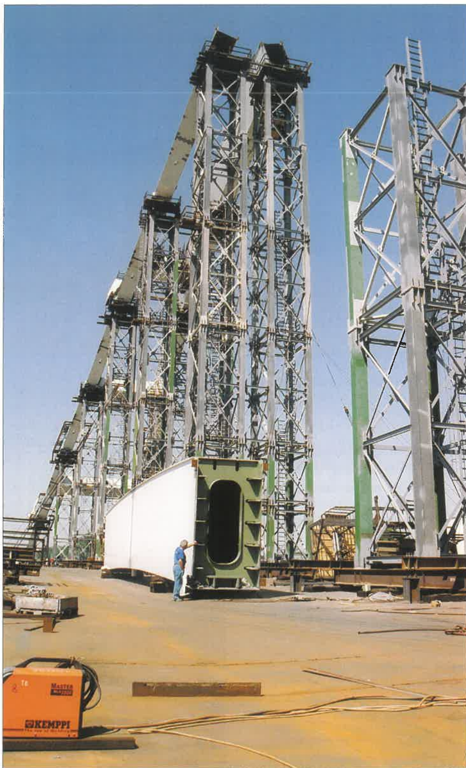
17. ábra. A képen egy beemelésre váró, ívszakasz látható. Az előtérben a mini hegesztő áramforrás. A hatalmas híd szerkezet legtöbb varratát 35 db ilyen gép segítségével készítették
