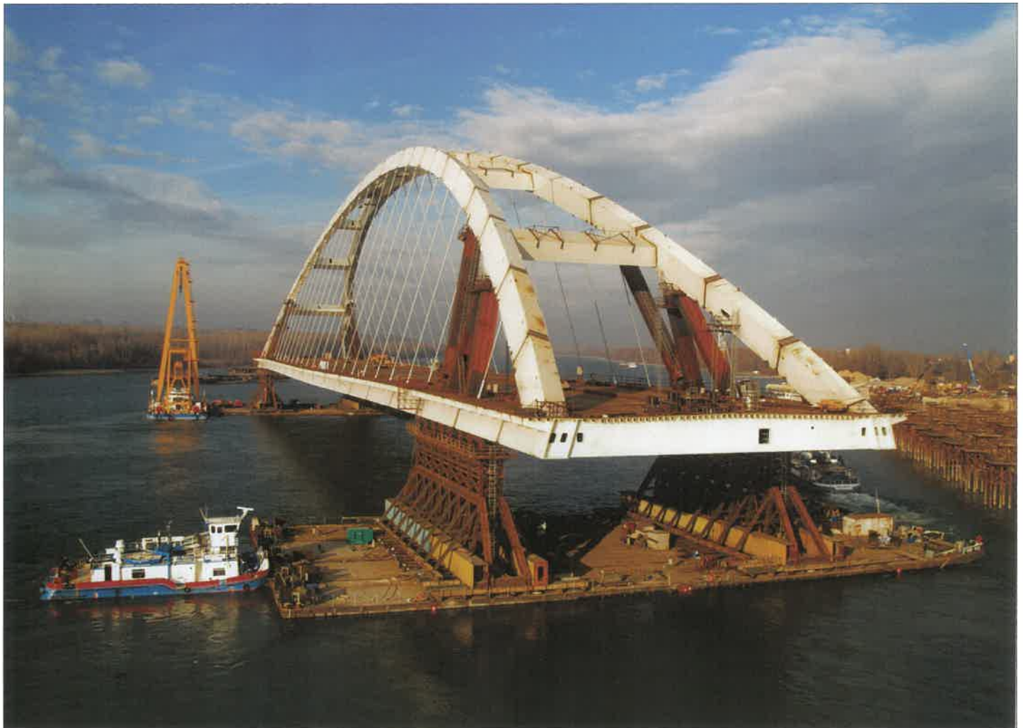
2. ábra. A mederhíd beúsztatása (2006.12.06.)
