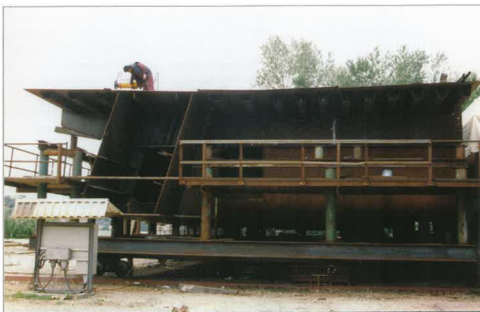
7. ábra. A hídkeresztmetszet egy szélső, főtartós része összehegesztés alatt
