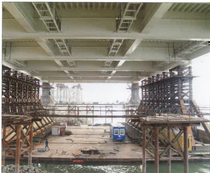
12. ábra. Az ideiglenes szerelőpilléren 6,5 m magasságba emelt híd alá beúsztak a bárkacsoportok (folyik a teherátvitel)
