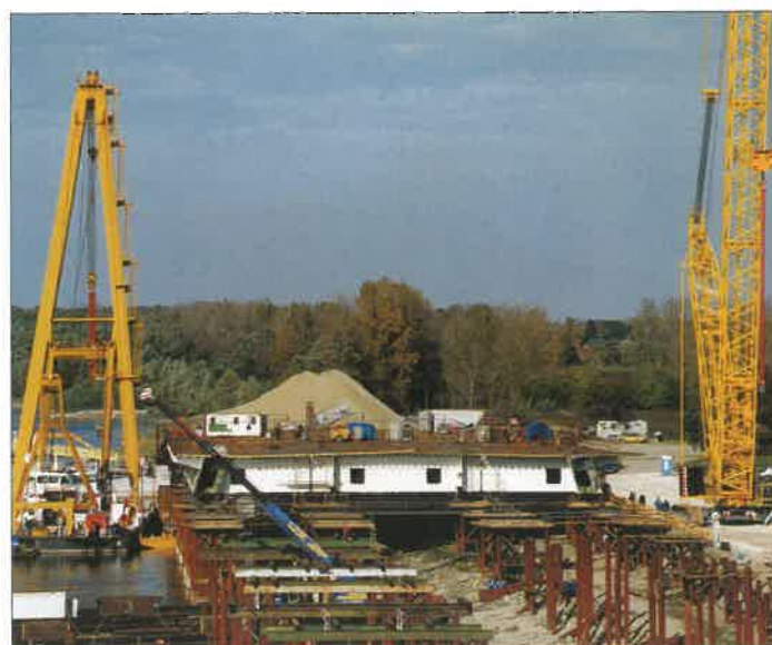
9. ábra. A híd északi végének helyszíni szerelése állványon (a víz felől úszódaru, a partról autódaru segítségével)
