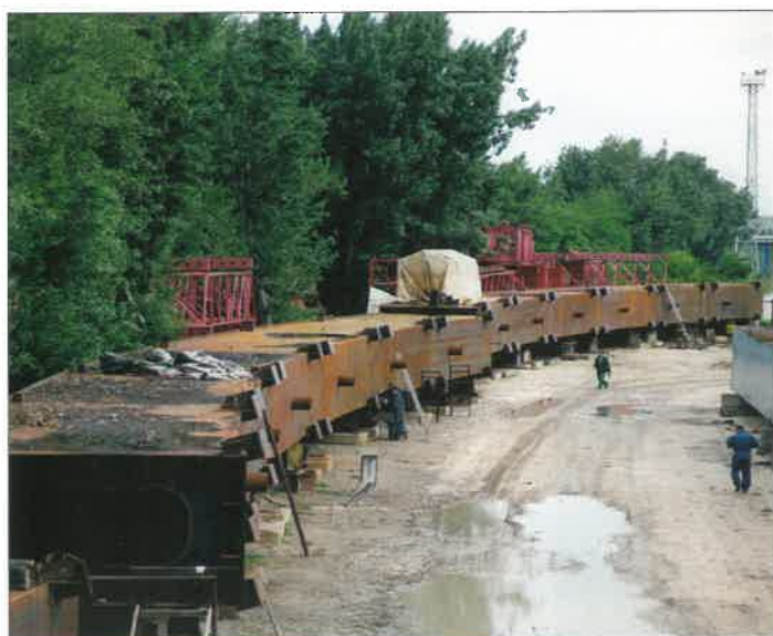
8. ábra. Az ívtartó pár egy-egy – hat-hat gyártási egységet magában foglaló szakaszának – előszerelése a csepeli telepen
