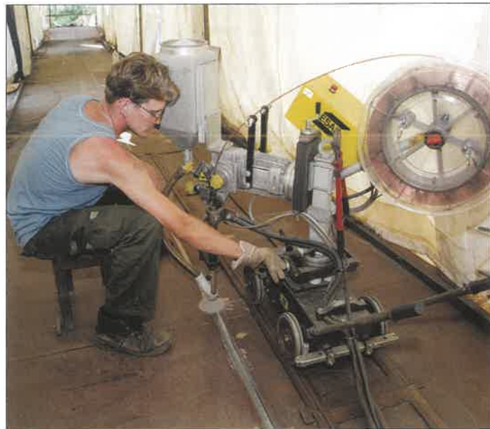
16. ábra. A pályalemez utolsó, záró varratának hegesztése (sátor védelme alatt)
