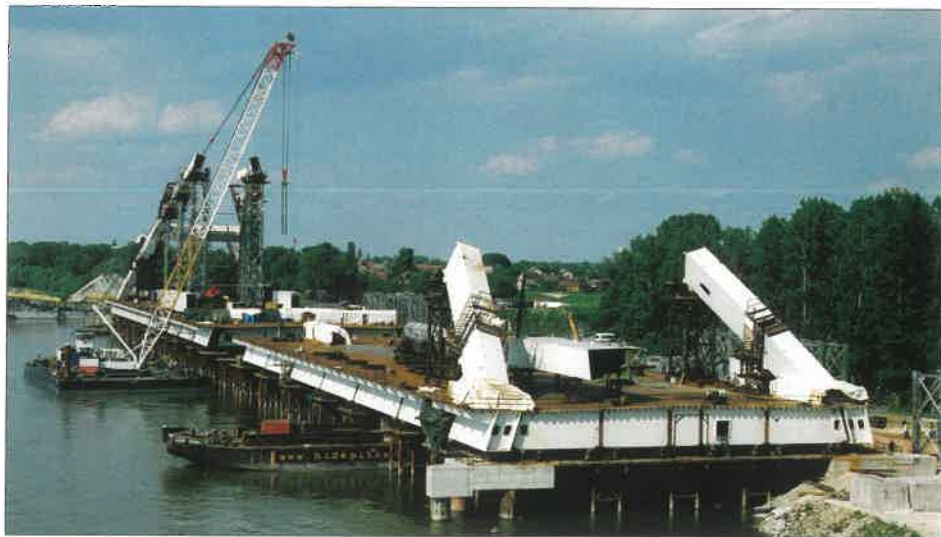
10. ábra. Az ívek szerelése mindkét oldalon folyik (de a merevítő tartó záró szakaszai még beépítésre várnak)
