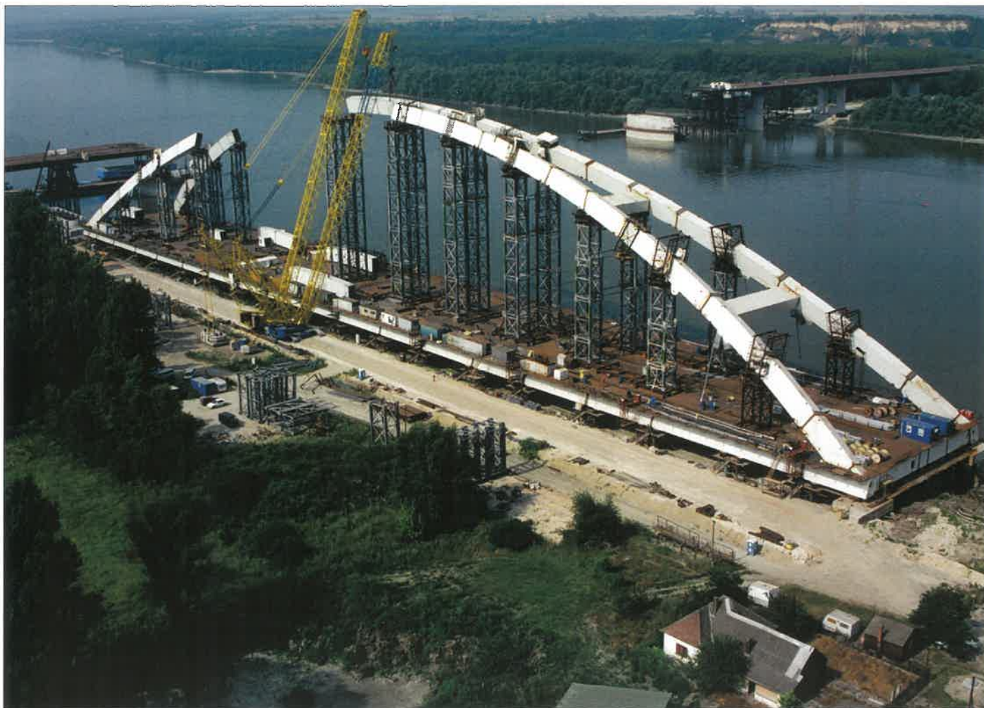
1. ábra. A mederhíd szerelése a Duna bal partján létesített állványon (2006.07.27.)
