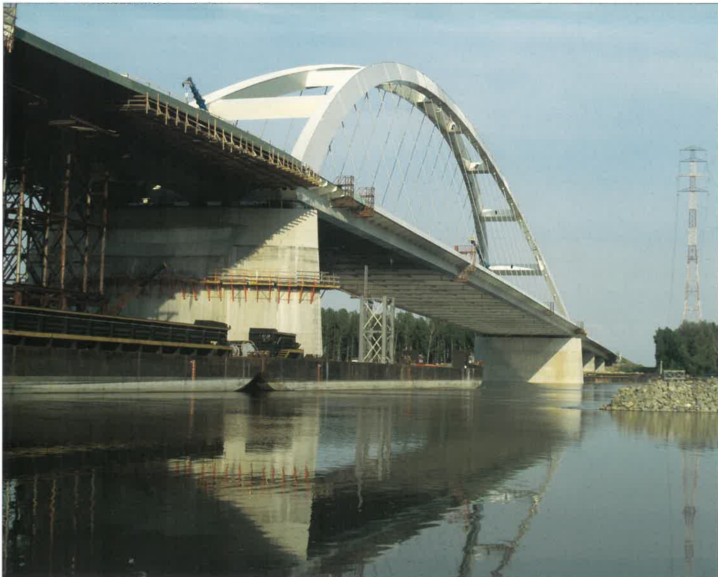
20. ábra. A mederhíd – 9 méteres emelés után a jobb-parton is a végleges helyén van, a pillérek „felbetonozása” is befejeződött (2007. 05. 17.)
