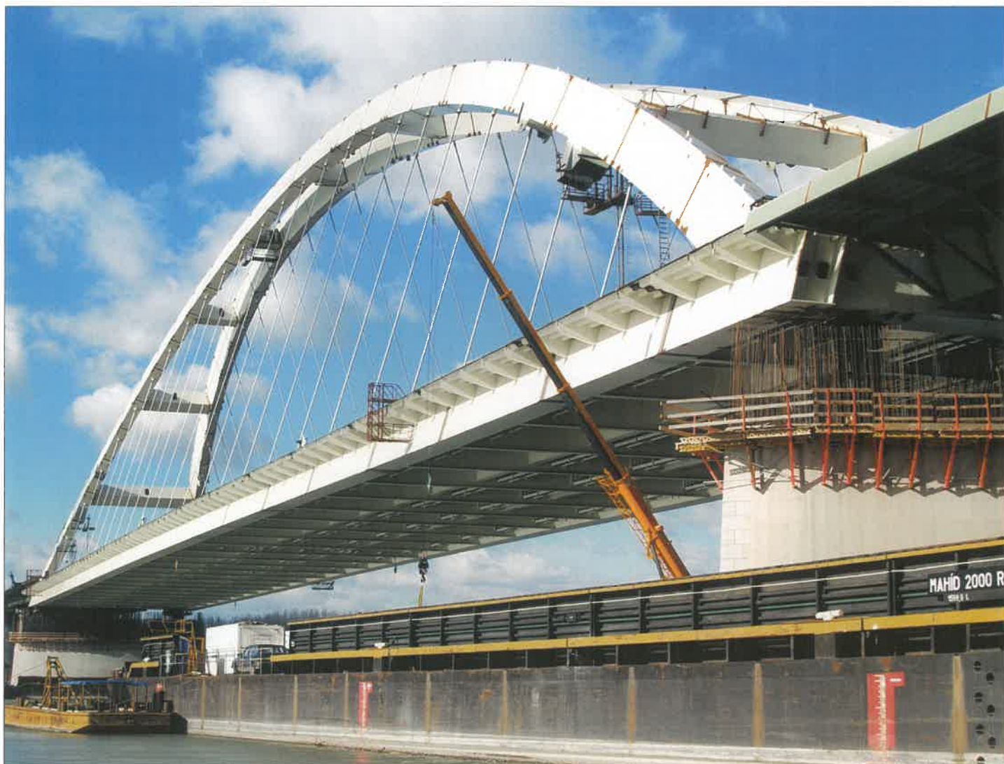
19. ábra. A bal-parton – 4,4 m emelés után, 2007 január 10-én – a mederhíd elérte a végleges, az ártéri hídval egyező szintjét. A képen a pillér hiányzó részének vasalása látható (2007. 02. 01)
