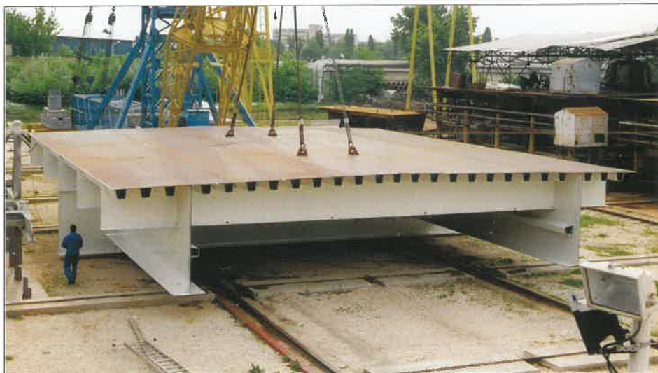
6. ábra. A hídkeresztmetszet középső szerelési egysége korrózióvédett állapotban
