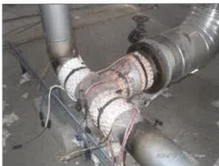
4. ábra. Csővezeték hőkezelése
