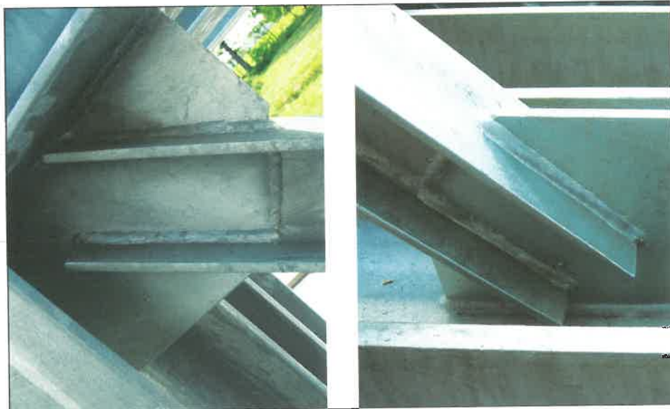
13-14. kép: Megfelelő küllemű varratok
