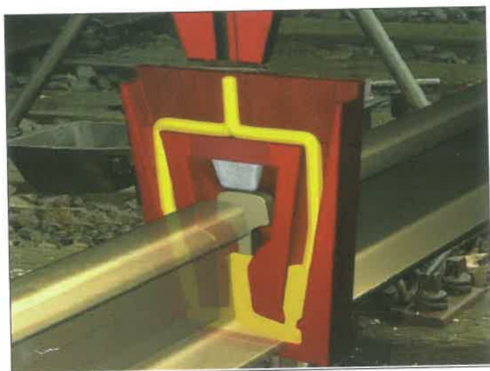
8. ábra HPW hegesztés. A termitacél beömlik az öntőformákba és feltölti a hegesztési hézagot
