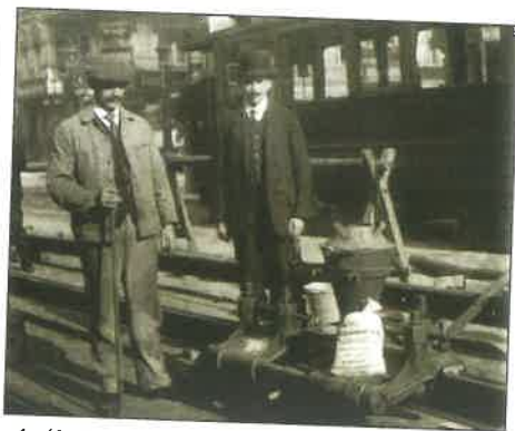
1. ábra Archív felvétel az aluminotermikus sínhegesztés kezdeteiből, Berlin, 1900.
