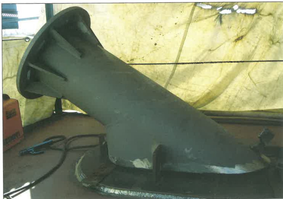
8. ábra A kábel-védőcső hegesztéshez előkészítve
