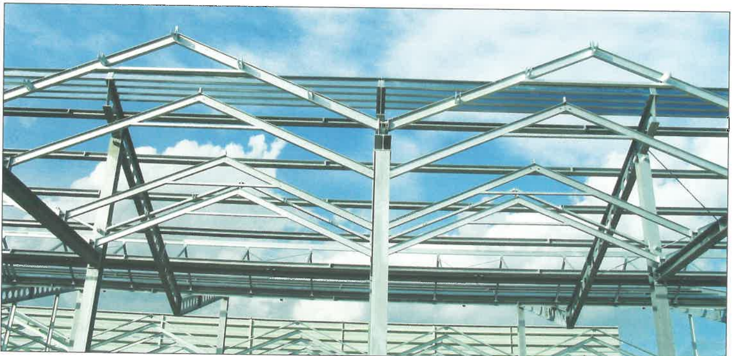
1. kép: Hegesztett acélszerkezet tűzhorganyzott kivitelben
