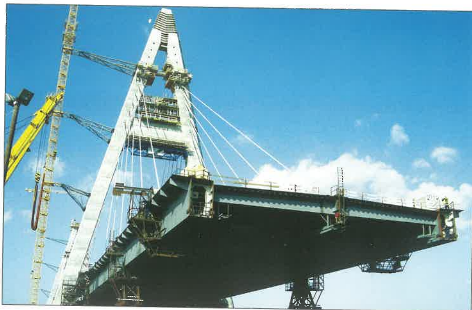
9. ábra. A helyszíni szerelés utolsó fázisai
