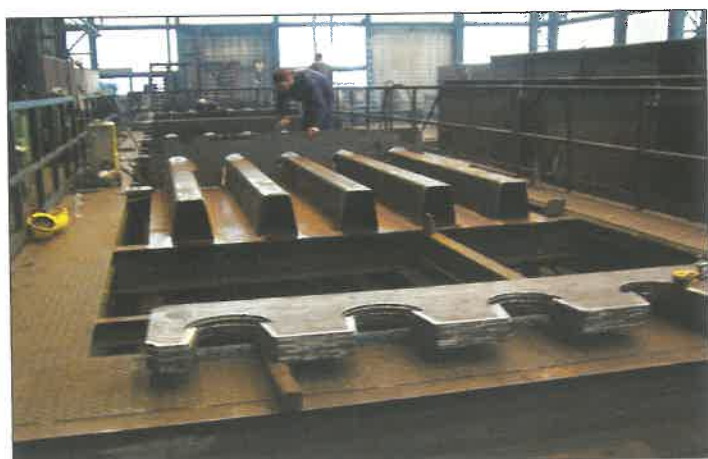
4. ábra A keresztartók ráépítése a pályapanelre
