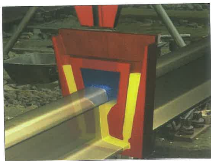
9. ábra HPW hegesztés. A termitacél beolvastja a kiegészítő ötvözőket tartalmazó konglomerátumot
