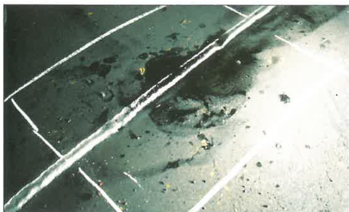
9. felvétel Hidegkötéses hiba felső lemezénél, beszívódott töltet-anyaggal, átmenő réssel.
