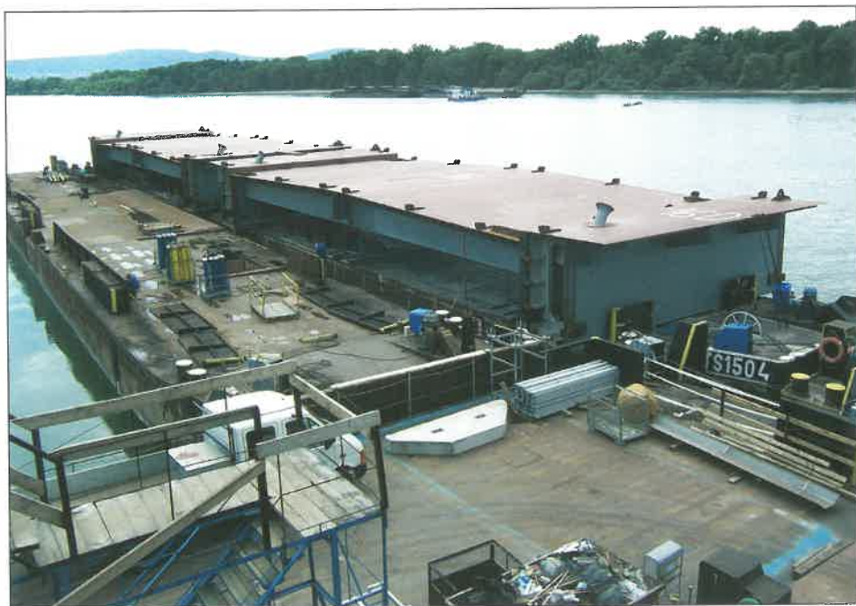
7. ábra Az előszerelt egységek helyszínre szállítása
