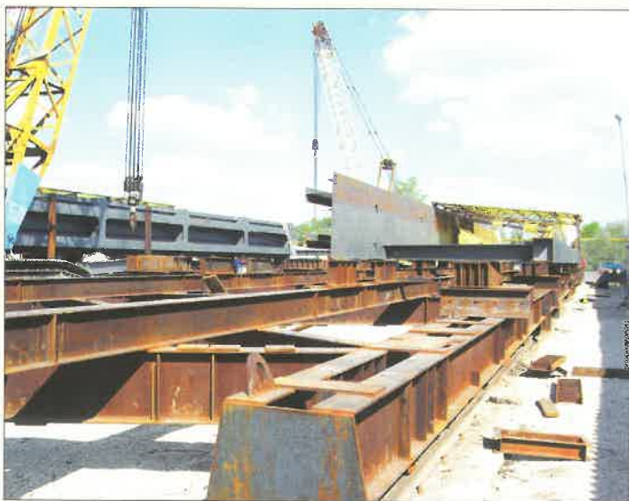
5. ábra. Kifektetett fél keresztmetszetek a szerelőterületen
