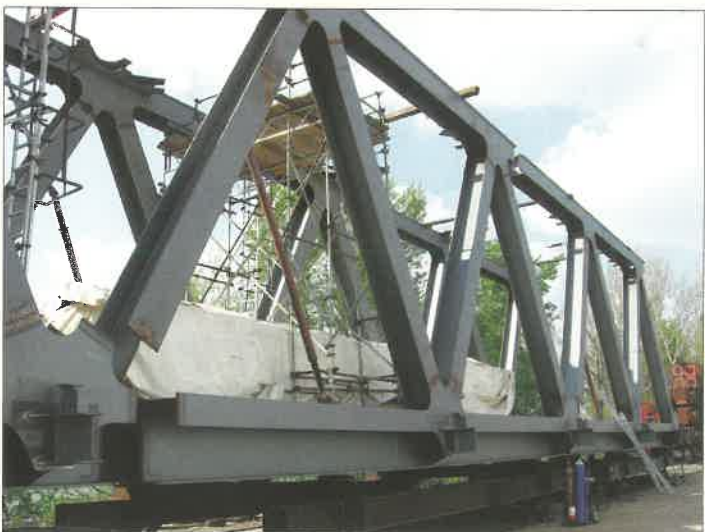
6. ábra. Teljes keresztmetszet összeállítása
