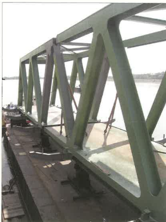
8. ábra. Bárkán készített keresztirányú toldás
