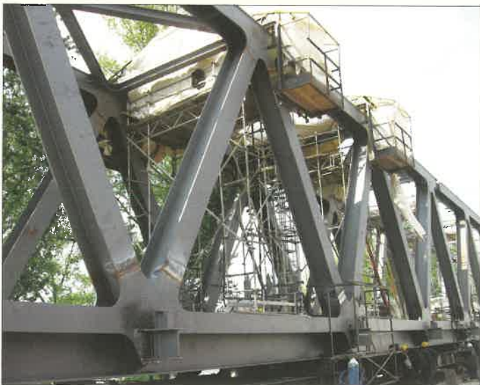
7. ábra. 31m-es szakaszok összeállítása
