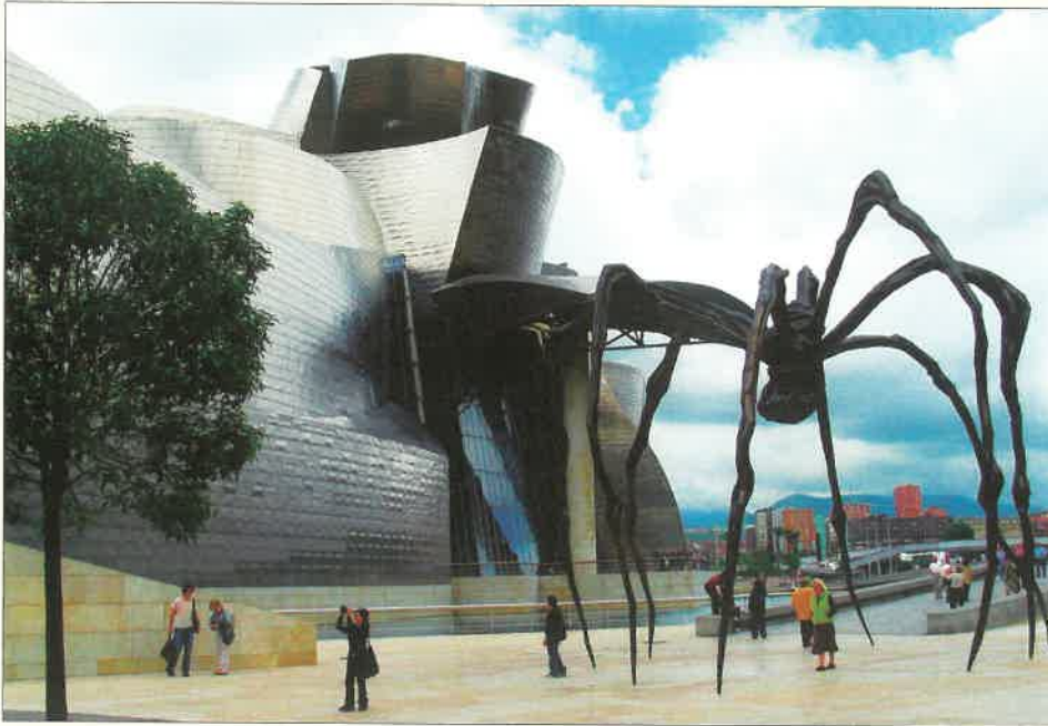
14. kép. A Bilbao-i Guggenheim Múzeum bejárat felőli oldala (látható a títán borítás)
