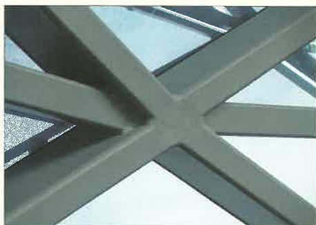
21. kép. A kettős kúp rácsos szerkezetének egy hegesztett csomópontja
