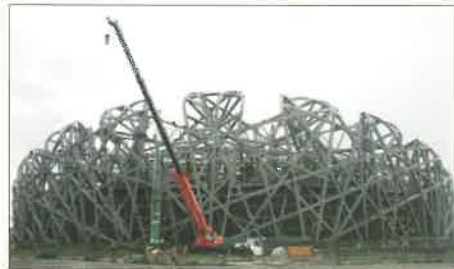
23. kép. A stadion acél tartóvázának építése
