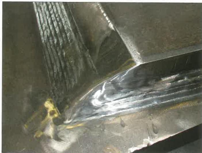
8. ábra. Ostkreuz, Berlin: Az övlemez erősítés hegesztett kötése közelről
