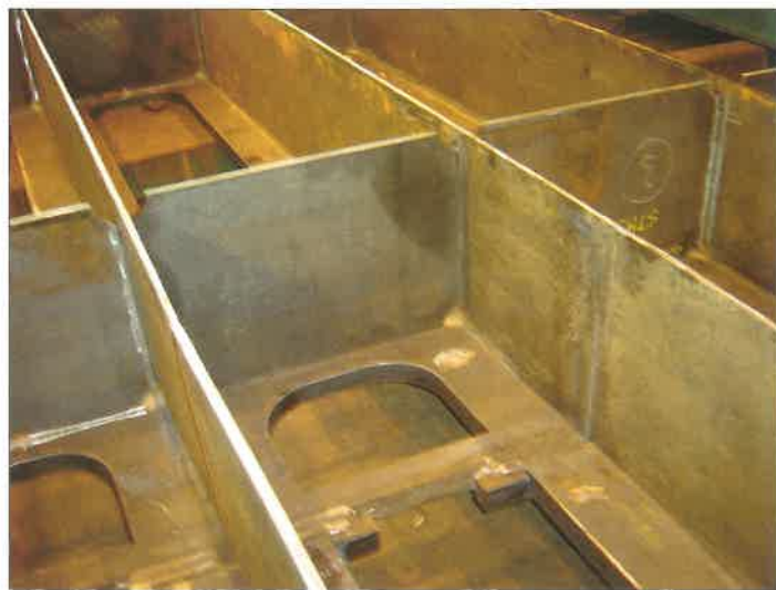
3. ábra. Oberhafenbrücke, Hamburg: Egy közbelső hídlemez gyártás közben (az alsó öv a hossz- és keresztartókkal)
