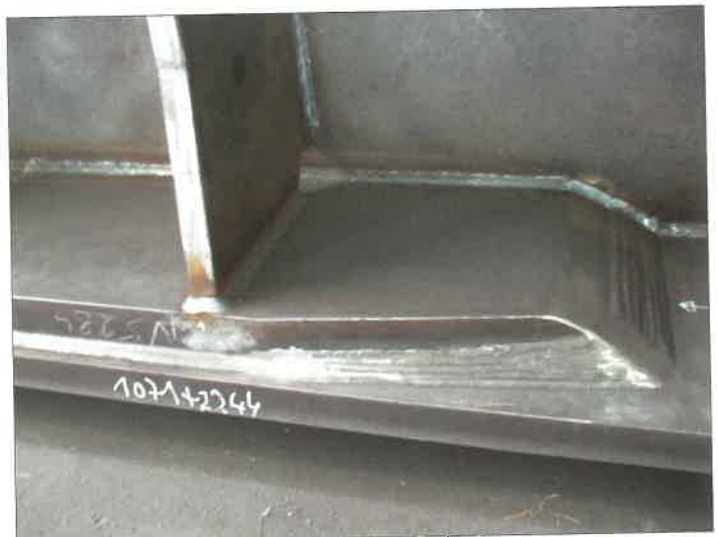
7. ábra. Ostkreuz, Berlin: A főtartók alsó övlemezének erősítése
