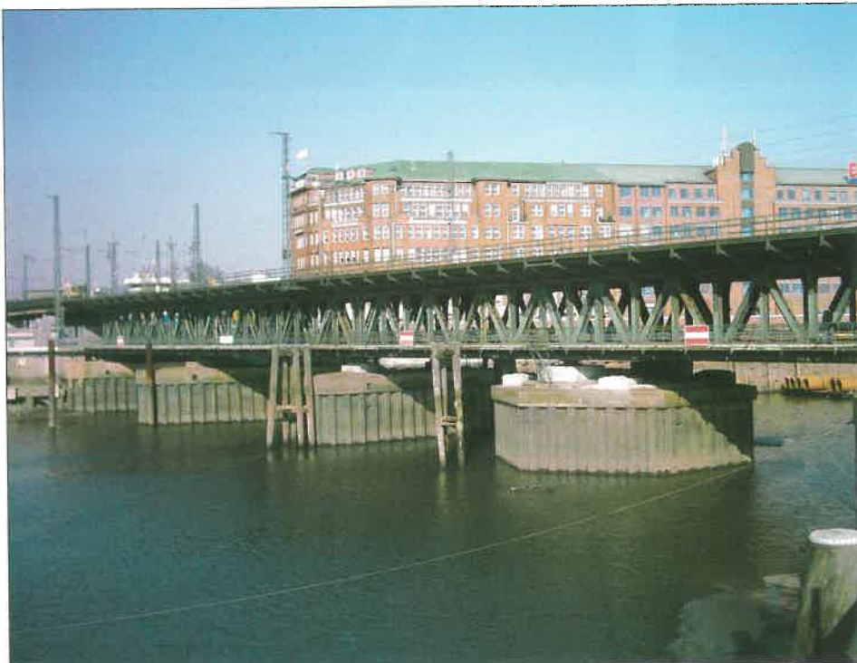
1. ábra. Oberhafenbrücke, Hamburg: Az Oberhafenkanal felett átívelő régi híd
