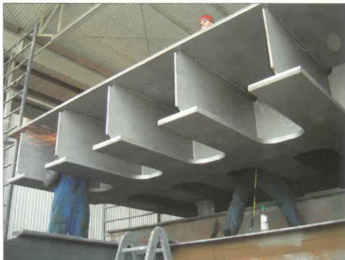
4. ábra. Oberhafenbrücke, Hamburg: Egy készrehegesztett hídlemez a szemcseszórás követő javítás közben
