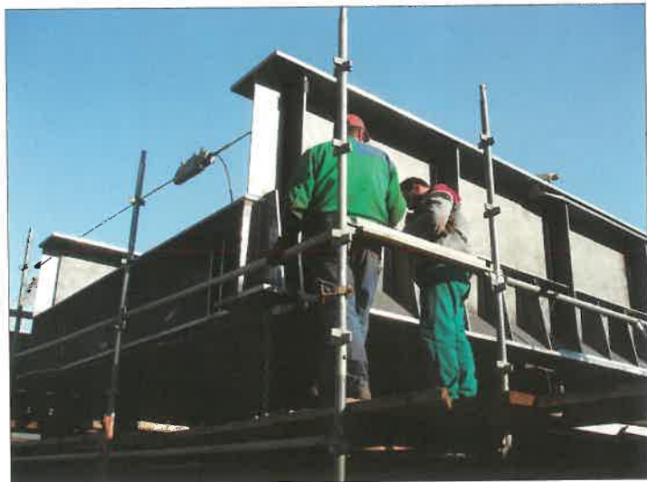
10. ábra. Ostkreuz, Berlin: A két főtartóból és a pályaszerkezetből összeállított első hídelem a szerelőállványon
