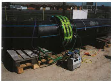
1. ábra. Nagy átmérőjű csöktetés kialakítása ivóvíz közműnél
