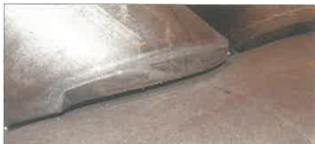
12. ábra. Varrat előkészítés rácsrudak bekötésénél
