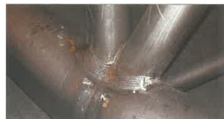
18. ábra. Rácsrudak átlapoló kötés kialakítással
