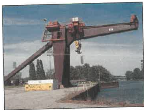
6. kép. 450 tonnás belvízi kikötői daru – Oberhausen / Németország
