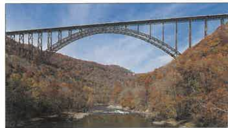
19. kép. New River Gorge Bridge – Fayetteville / West Virginia, USA
