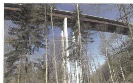
12. kép. Viaduc des Vaux – Yverdon les Bains / Svájc
