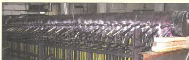
1. ábra. Gőz kollektor cső a csónkokkal
