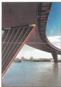
14. kép. Shank Millenium Bridge – Peterborough / Anglia
