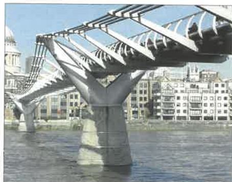
11. ábra. Millennium Bridge – London
