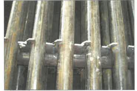
6. kép. Egy összeszerelt egység: alátámasztó csövek keresztirányú csövekkel kiegészítve (fűtőfelület), amelyen keresztül áramlik a gőz, a villamosenergia előállításához.
