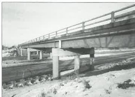
4. Clive Road Bridge – Des Moines, Ohio, USA
