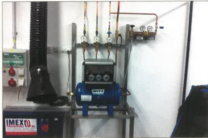
4. ábra. A központi gázellátás keverője
