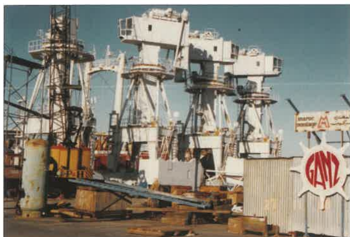
15. kép. A negyedik gépház beemelése.
