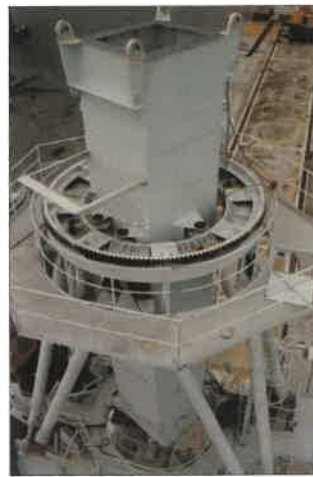
14. kép. Támgörgők beállításának befejezése
