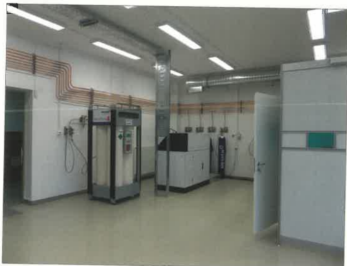
6. ábra. Lézerlabor gázellátás
