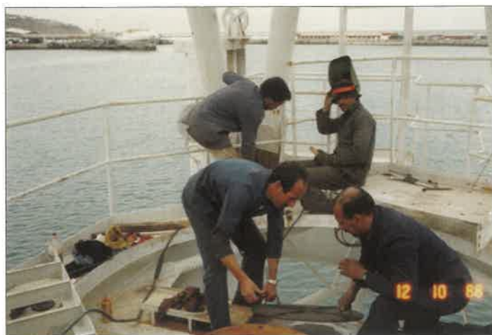
12. kép. Talpcsapágy előkészítés
