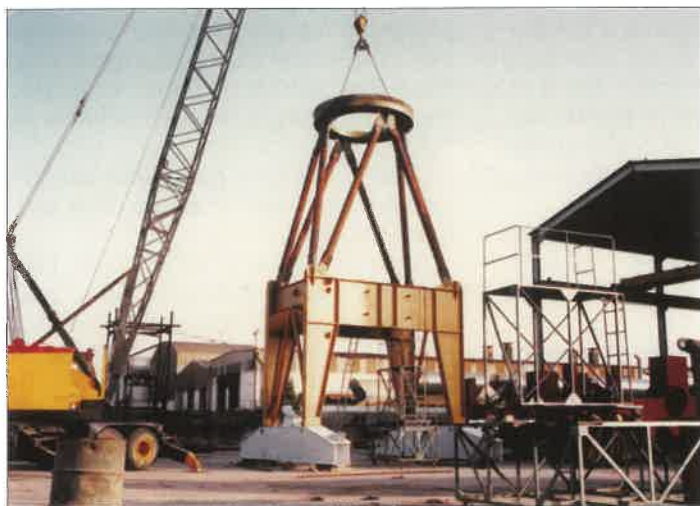
10. kép. Fogaskoszorú járófelület beemelése
