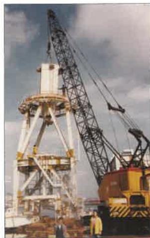
13. kép. Az északi daru tornyának az emelése
