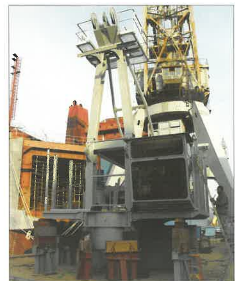
29. ábra. A forgóváz felkészítése a gém fogadására
