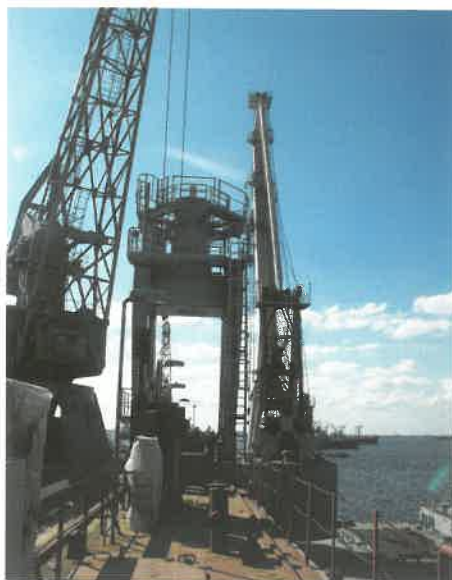
31.2. ábra. A portál és a torony beemelése végleges helyén
