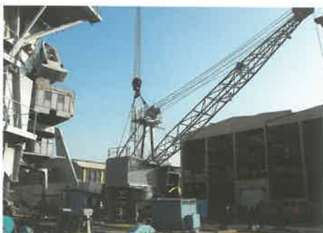
32. ábra. A fülke, gépház, gép emelés kezdete
