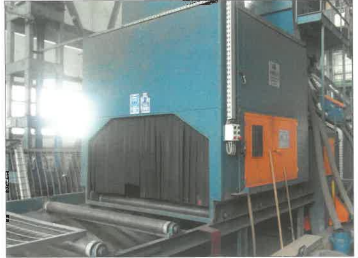
13. ábra. A lángvágó berendezés (5)
