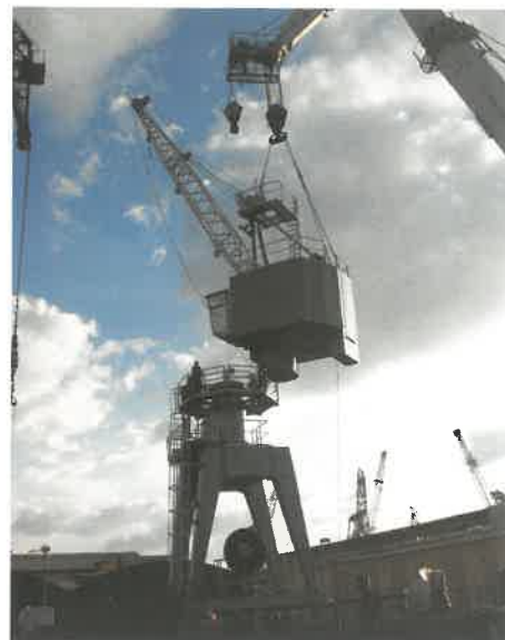
33.1. ábra. A gépház és a gép beemelése közel a befejezéshez
