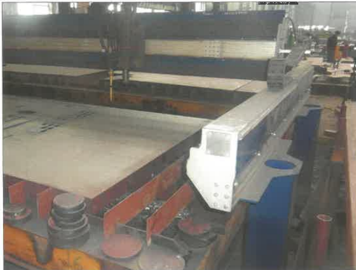
14. ábra. A lángvágó berendezés (5)
