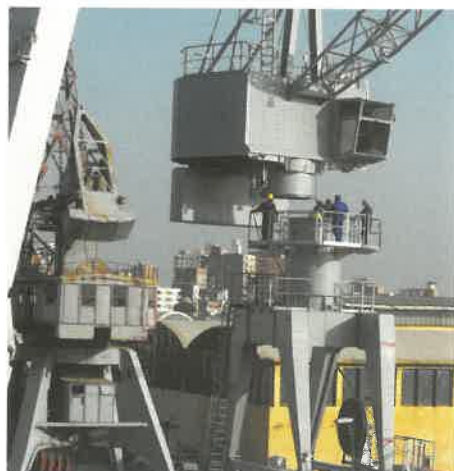
33.2. ábra. A gépház és a gép beemelése utolsó előtti pillanata
