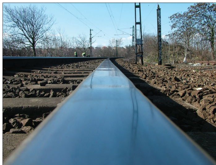
3. ábra. Sínfej hullámos kopása, mely általában ív belső sínszálában keletkezik
