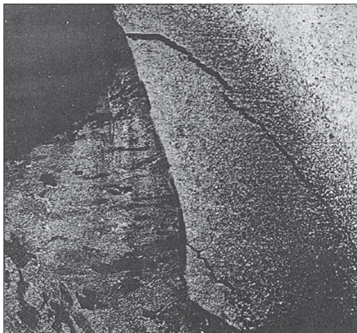
1. ábra Repedés a hőhatás övezetben [4]
