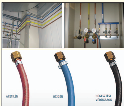
3. ábra Példa a színjelölés alkalmazására gázvezeték, gáztömlők esetére [2]
