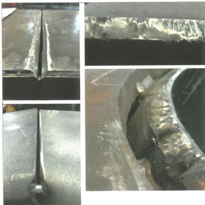
2. ábra. A képeken látható élelőkészítésekbe és illesztésekbe „kódolva” vannak a varrathibák.
