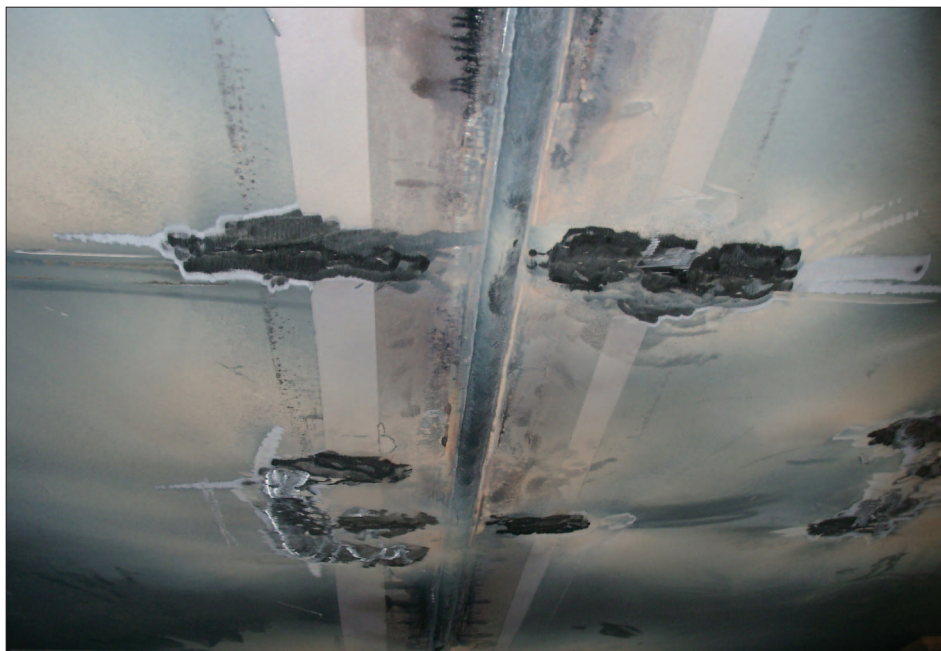
9. kép. A varrat gyöke (a köszörülés nyomok a rögzítő „lakatok” helyei)
