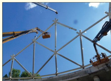
19. kép Előszerelési egység helyére illesztése
