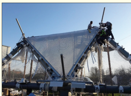
16. kép A fólia próbaszerelése
