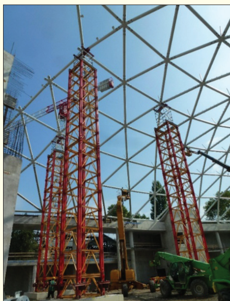
29. kép PERI állványok a Biodombban
