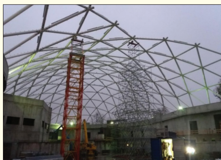
30. kép Kétféle PERI állványrendszer a 3. dombban
