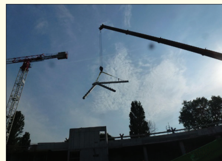
18. kép Előszerelési egység a darun
