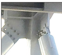
11. ábra. Hiányos csavarozás
