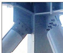
11. ábra. Hiányos csavarozás
