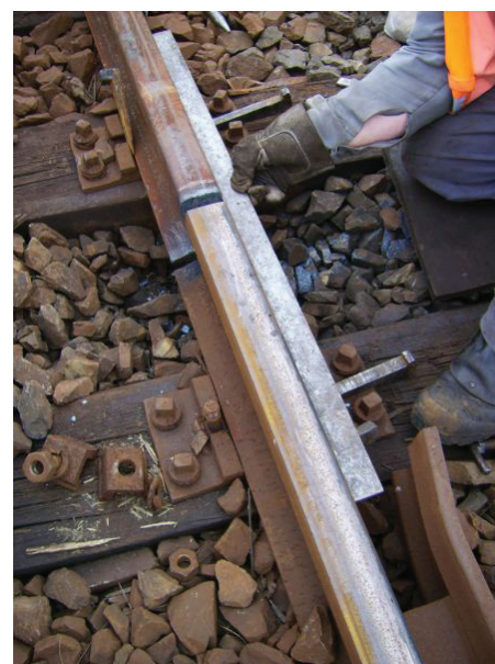
17. ábra: A sínvégek vízszintes beállítása
