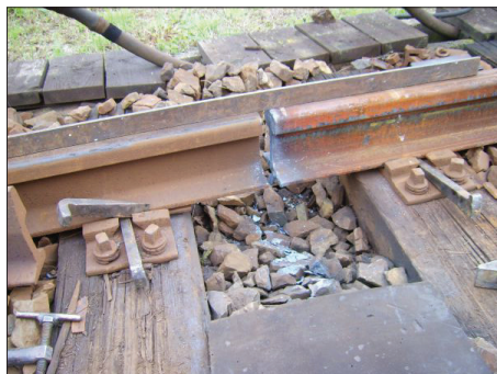
18. ábra: Függőleges beállítás
