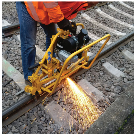
21. ábra: Sínköszörű a sínfej formai kialakításához
