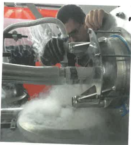
7. ábra: Beépített csőszakaszok varratának helyszíni hőszokkoltása cseppfolyós nitrogénnel
