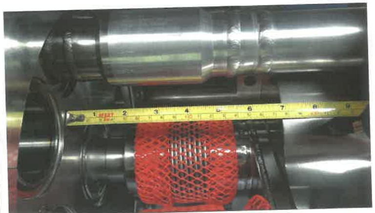
6. ábra: Az ausztenites és alumínium ötvözetű csövek összehegesztése bimetal paszdarabbal valamint egy radiális kompenzátor beszerelése
