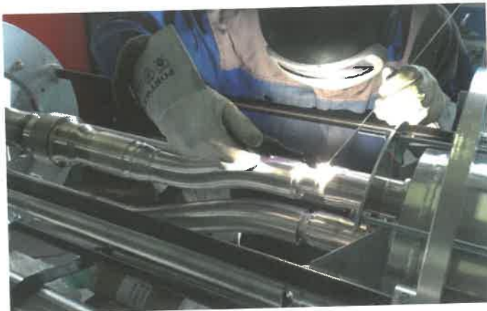
5. ábra: A reflektor kamra és a hőcserélő összehegesztése duplafalú alumínium / ausztenites csövekkel az összeállító segédberendezésben
