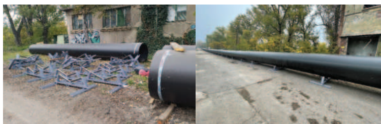
10. ábra A kivitelező által készített tökéletes görgősor
