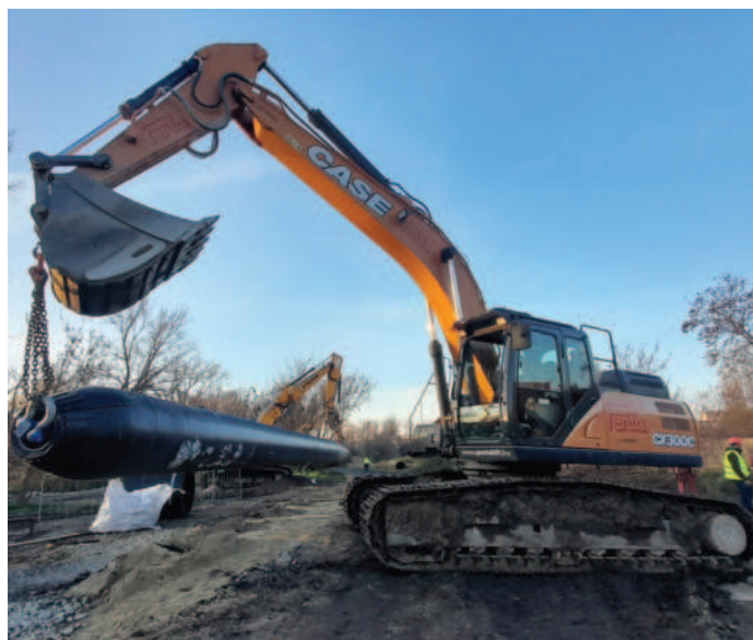
1. ábra Behúzófej indítása munkagépekkel
