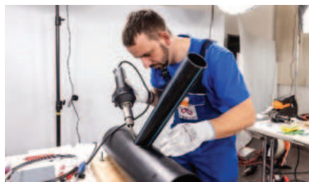
Polietilén csövek hegesztése forrólevegős hozaganyagossal
