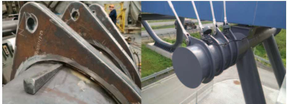
10. ábra Függesztőkábelek bekötése a kereszttartóba (Glogoczów)
