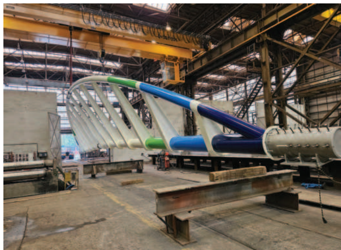
16. ábra Szczecin íves tartó kiszállítása
