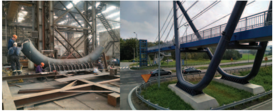
9. ábra Csőtartó és támasz csatlakozása (Glogoczów)
