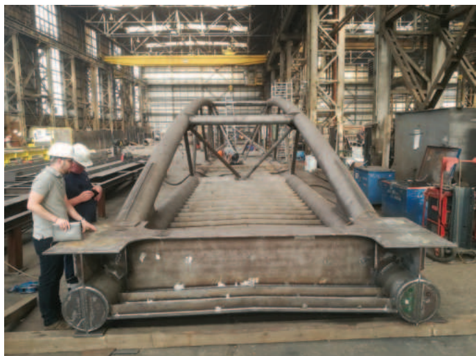
15. ábra A Tisza híd ártéri nyílásának próbaszerelése (pályával lefelé fordított helyzetben)
