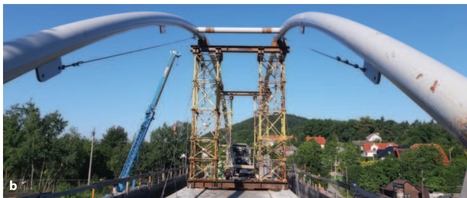
6. ábra Íves tartó gyártása a) 12m-es egyenes cső toldása b) hajlított tartó helyszíni szerelése (Myslenice)
