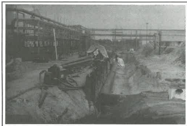
8. ábra. Csővezeték-szakaszok előgyártása.
