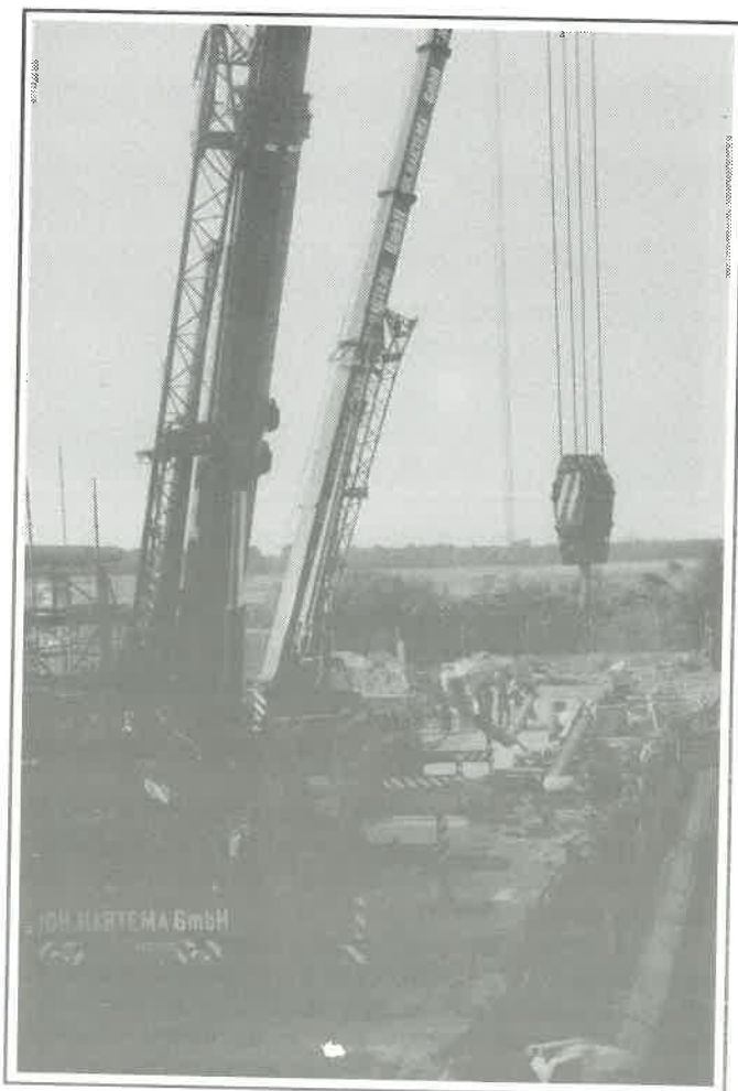
10. ábra. Csőszakaszok bemelése darukkal.
