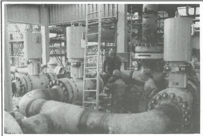
7. ábra. Hidraulikus csavarhúzó készülék használata.
