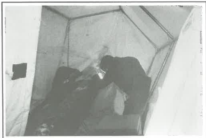
12. ábra. Hegesztés egymás mellett szűk helyen, a csőárokban.
