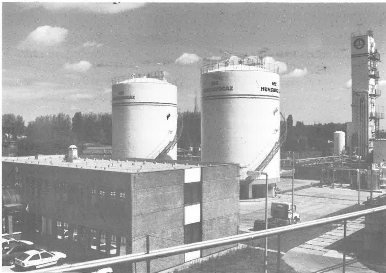
2. ábra Az új, egyenként 1.000.000 m 3 -es oxigén és nitrogén tartályok az MGH újpesti telepén
