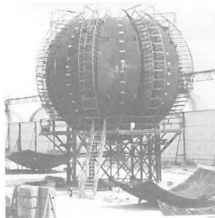
3. ábra Az összehegesztett alsó süveg- és palástrész (a függőleges varratok hegesztésénél alkalmazott létra-állványokkal)
