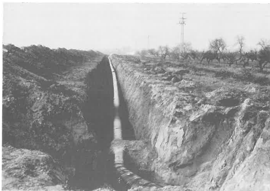
1. kép 610 mm átmérőjű csővezeték hegesztett, szigetelt állapotban
