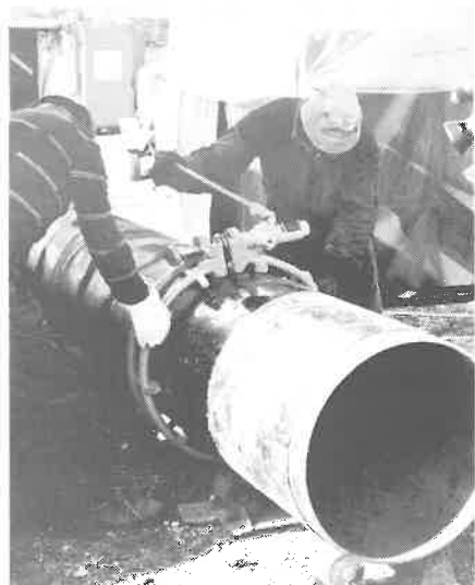
7. kép. Hidraulikus illesztő és központosító készülék
