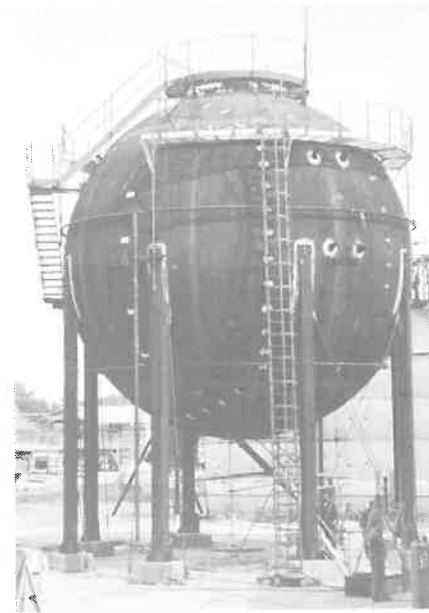
4. ábra A már saját lábaira helyezett, befejezés előtt álló tartály
