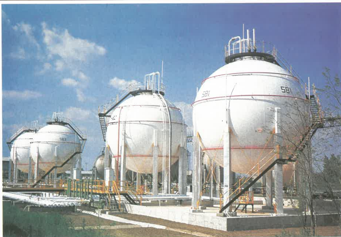
SZÁZHALOMBATTÁN 1994-BEN ÜZEMBEHELYEZETT 4 DB 500 M 3 ŰRTARTALMÚ, 1,7 MPA ÜZEMI NYOMÁSÚ GÖMBTARTÁLY. TERVEZTE ÉS KIVITELEZTE: GANZ ACÉLSZERKEZETI VÁLLALAT
