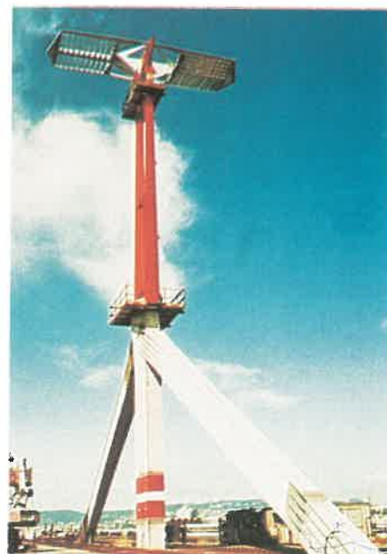
15. kép A kész pilon a ferde felfüggesztő rudakkal
