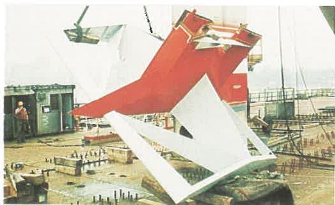
16. kép. A bonyolult kialakítású csúcsszerkezet a beemelés megkezdésekor
