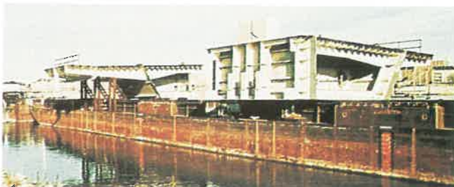
12. kép. Uszályra szerelt, beemelésre váró két fél híd keresztmetszet
