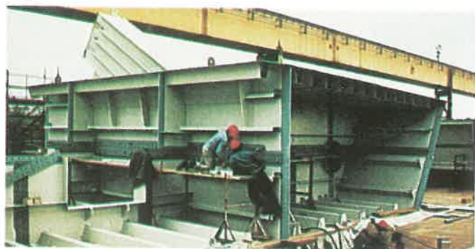
9. kép. A ferde rudas keresztmetszet (korrózióvédelem utáni) végleges összeszerelés közben a Lágymányosi telepen
