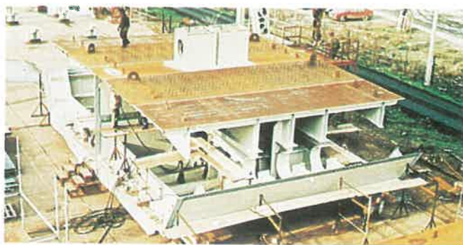
10. kép. A piloncsatlakozásos keresztmetszet végleges összeszerelés közben a Lágymányosi telepen
