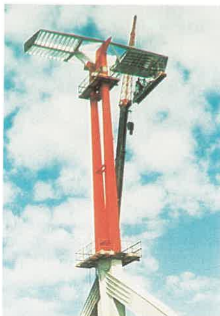
14. kép A pilon csúcsszerkezet a tükörtartó szerelésekor
