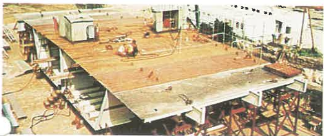
11. kép. Teljesen összeszerelt keresztmetszet pályalemez hosszvarratainak hegesztése Lincoln fedett ívű automatákkal
