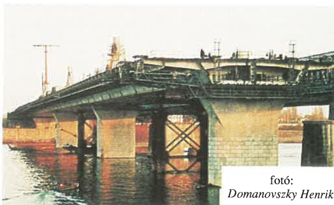
17. kép. A négy nyílásban már felszerelt balparti hídszakasz (kb. 350 m, 1994 december 2-i állapot)
