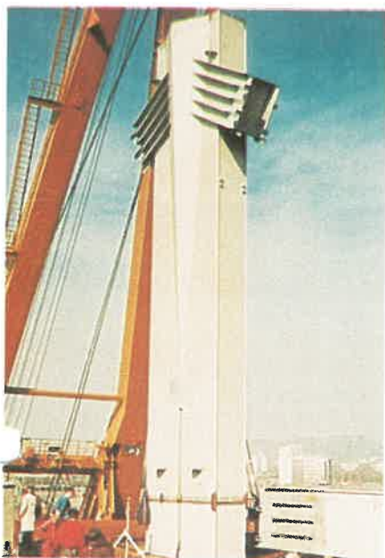
13. kép. A pilontörzs beemelés alatt
