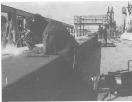
2. ábra Szegélytartó keresztvarratának hegesztése
