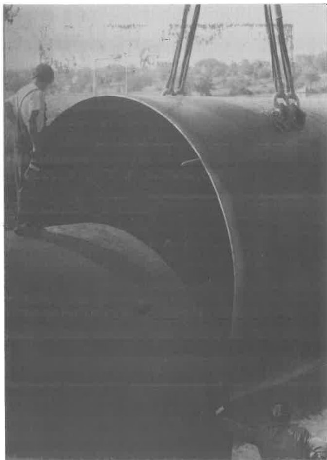
6. ábra A tartályfelek összeillesztése vezetőlapok segítségével
