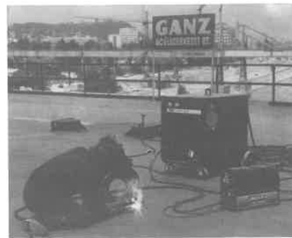
3. ábra Szerkezeti elem felhegesztése
