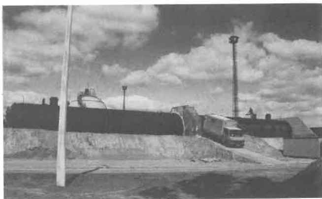
1. ábra A gáztartály két félből történő összehegesztése a telepítés helyszínén
