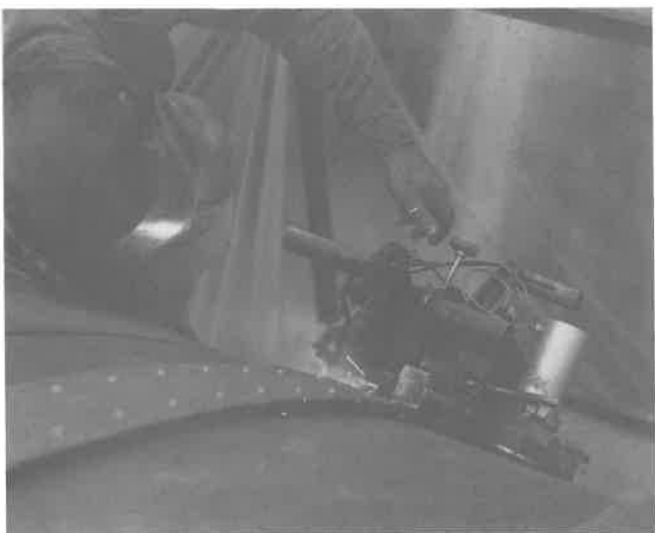
4. ábra A helyszíni zárókörvarrat hegesztése
