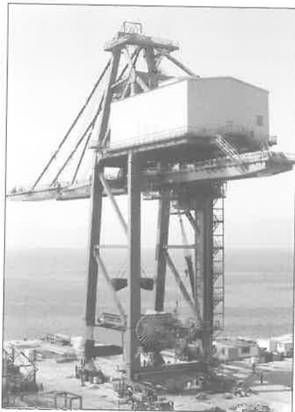
1. kép 2000 t/óra teljesítményű markolós érckirakó daru szerelés alatt (1991)
