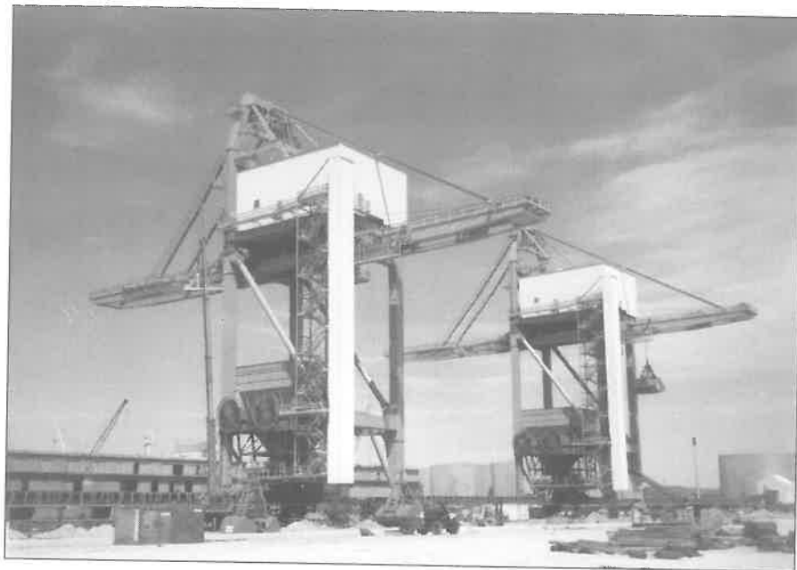
2. kép 1500 t/óra teljesítményű markolós szénkirakó daruk (1993)
