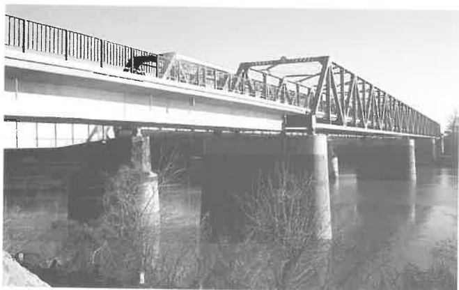
4. kép Az első hegesztett, rácsos, vasbeton pályalemezes híd Tiszafürednél (elkészült 1966-ban, nyílások: 30,0+3x70,0+30,0m)
