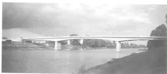
3. kép Az első korszerű, ortotróp pályalemezes hegesztett híd a Tisza felett Szolnokon (elkészült 1962-ben, nyílások: 54,8+79,3+54,8 m)
