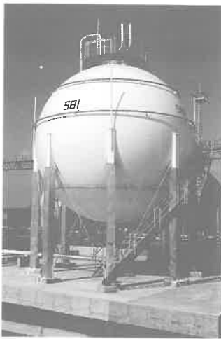
19. kép 500 m 3 -es 17 bar üzemi nyomású gömbtartály
