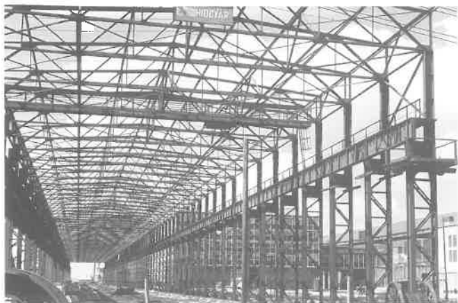
9. kép Az első korszerű hegesztett épületacélszerkezet szerelése 1960-ban
