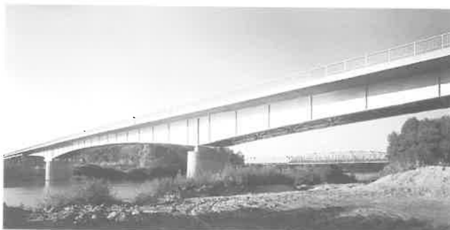
6. kép A vasbeton pályalemezes algyői Tisza-híd (elkészült 1974-ben, nyílások: 57,6+102,4+57,6 m)
