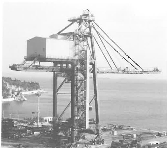
24. kép Hajókirakó óriásdaru a szerelés befejezése előtt (kapacitás: 2600 t/h érc, magasság: 61 m, gémhossz: 93 m)
