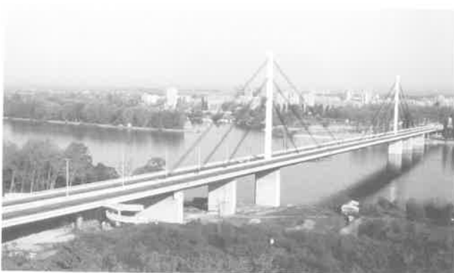
8. kép A Novi Sad-i (Jugoszlávia) ferdekábeles Duna-híd (elkészült 1981-ben, nyílások: 4x60,0+2x60,0+351,0+2x60,0+3x60,0 m)
