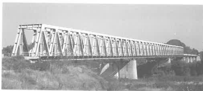
7. kép A csongrádi vasúti Tisza-híd (elkészült 1985-ben, nyílások: 107,7+120,0+107,7+4x42,0 m)
