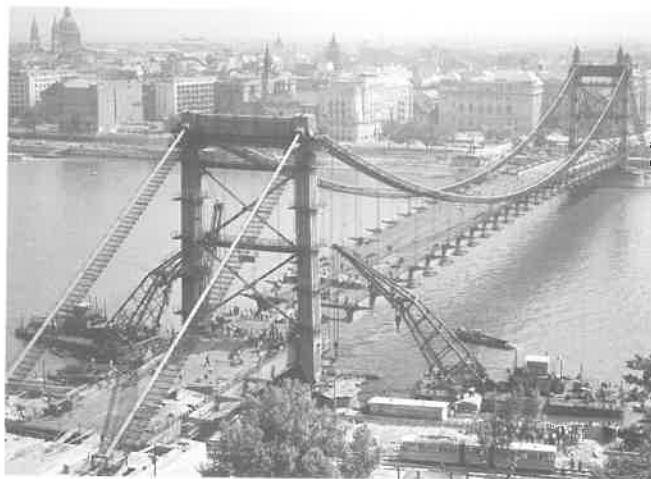
5. kép Az utolsó 100 tonnás pályaszerkezeti egység beemelése a budapesti Erzsébet kábelhídon, 1964-ben (nyílások: 44,3+290,0+44,3 m)
