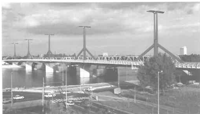
11. kép A Lágymányosi Duna-híd (elkészült 1995-ben, nyílások: 49,3 + 4 \times 98,5 + 49,3 m)
