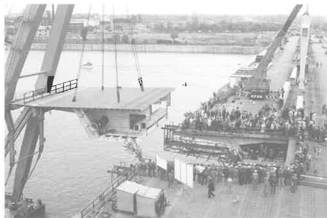
12. kép A Lágymányosi híd utolsó (fél keresztmetszeti) egységének beemelése (1995. május 18-án)
