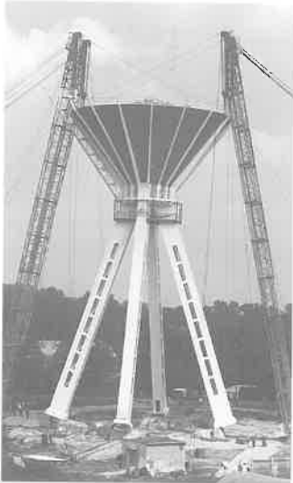
18. kép 2000 m 3 -es, 45 m magas víztorony szerelése
