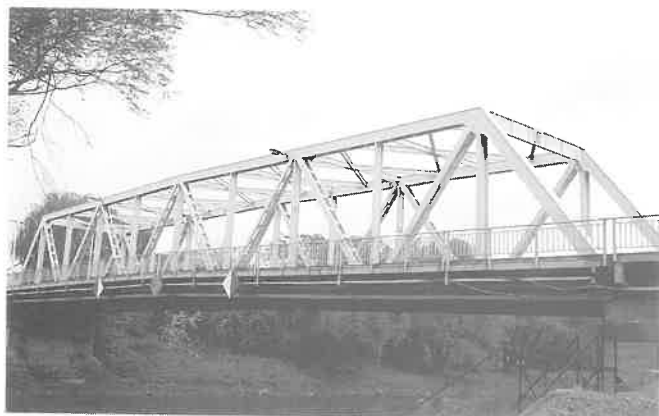
2. kép Az első hegesztett híd Győrben, több mint 60 éves üzem után (épült 1933-ban, fesztáv 53,1 m)
