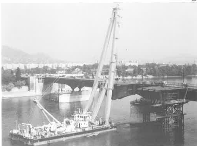
13. kép Az Arpád-híd 100 t-át meghaladó tömegű szerelési egységének beemelése a pesti Dunaágban, a régi híd kifolyási oldalán, 1981-ben (nyílások: 82,0 + 2 \times 103,0 + 82,0 m, a teljes híd öt önálló szakaszból áll és 928 m hosszú)
