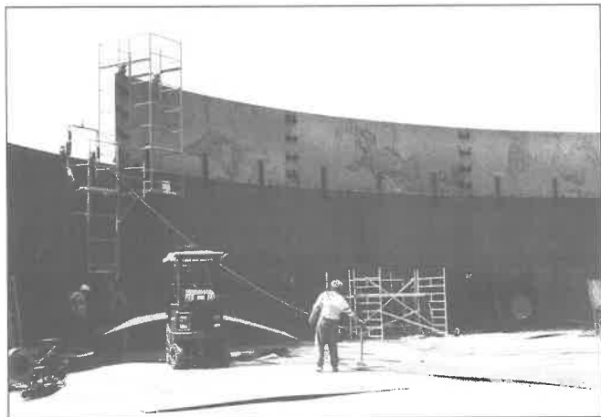
2. ábra. A tartályköpenyek összeállítása
