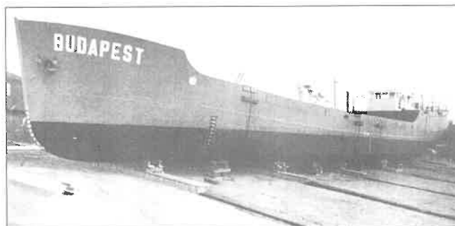
A RIMAGIL ELEKTRODÁKKAL HEGESZTETT „BUDAPEST” DUNA-TENGERI HAJÓ (Ganz-Danubius R. T. Hajógyára)
