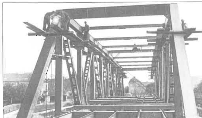
GYŐRI KÖZUTI RÁBAHÍD SZERELÉSE, ELŐTÉRBE 2 HEGESZTŐVEL (Magyar Wagon- és Gépgyár R. T. Győr-Budapest)
