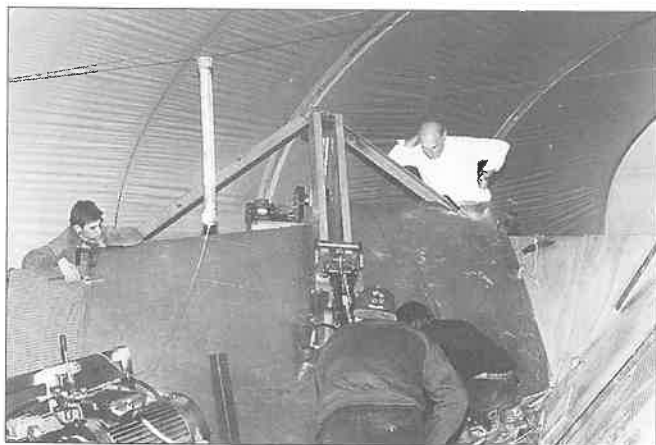
4. ábra A keverő dörzshegesztőgép prototípusa
