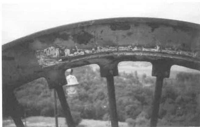
5. ábra. A kifúvatott és hegesztésre előkészített perem
