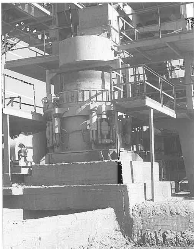
1. ábra. A kőtörőberendezés üzemi állapotban
