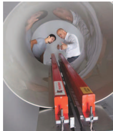
11. ábra Lemez tompahegesztőgép tartálypalást hegesztés közben [6]
