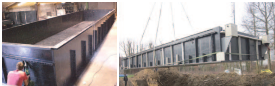
15. ábra Kettősfalú merevített lemezből készült szögletes medencék [11]
